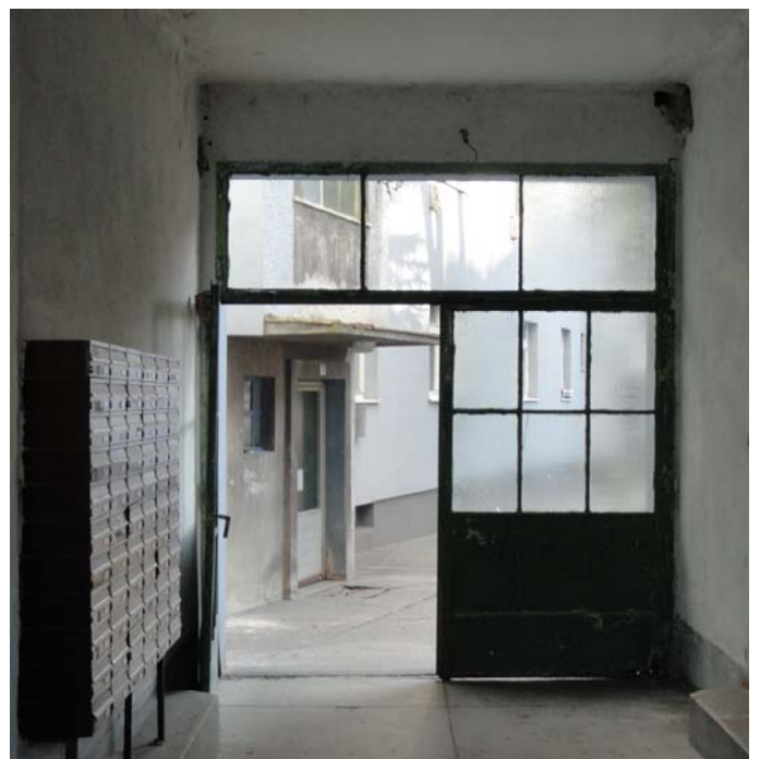
Foto 4 Pohľad z interiéru - pohľad D (pohľad do dvora bytového domu)
