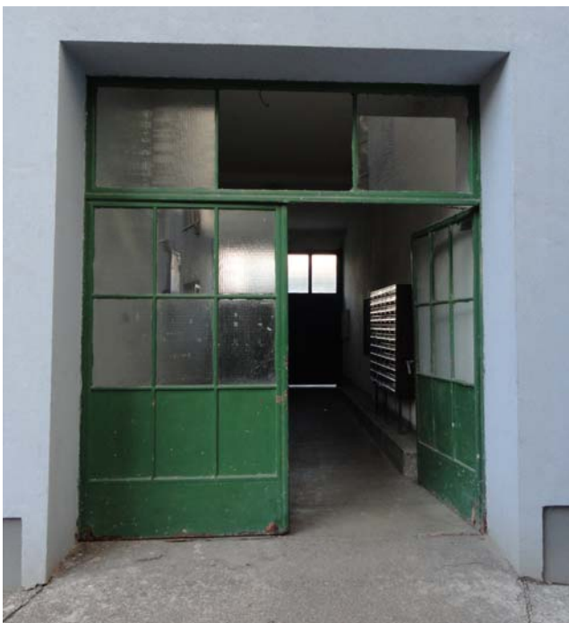
Foto 3 Pohľad z exteriéru - pohľad C (pohľad z dvora bytového domu)
