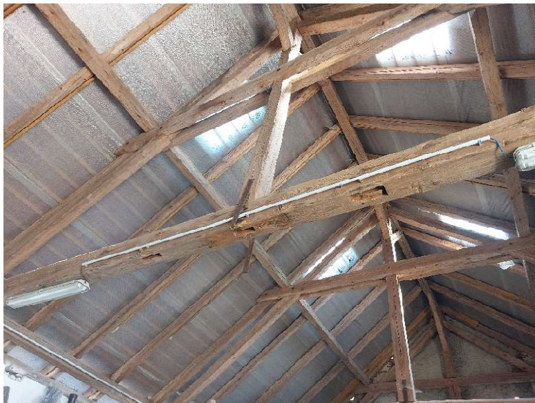
Obrázek č. 2 - Uvolnění/odepnutí ocelových táhel u prvků, které mají působit v tahu
