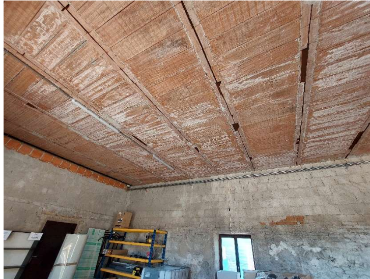
Obrázek č. 5 – Konstrukce stropu HURDIS
