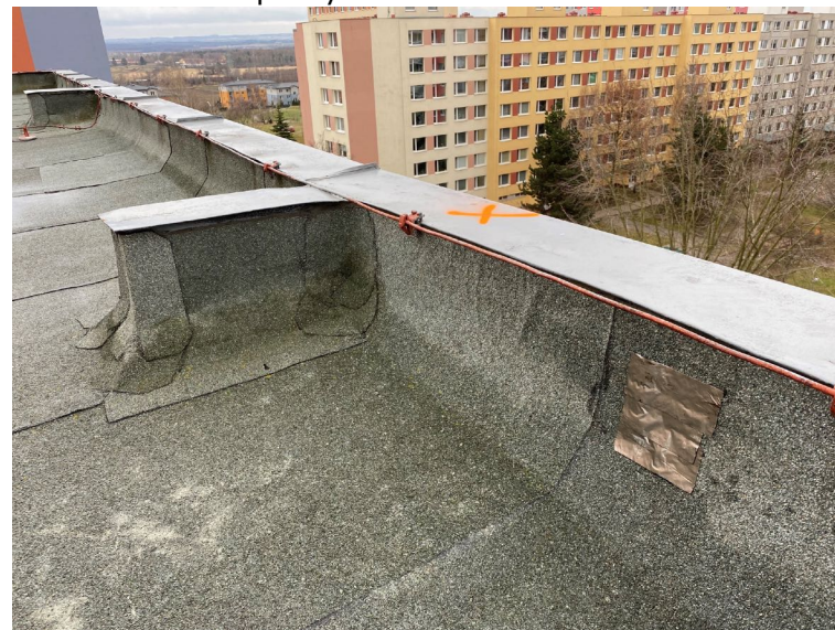
Obrázek 38: Otvor pro dýmovou zkoušku DZ1 utěsnění
