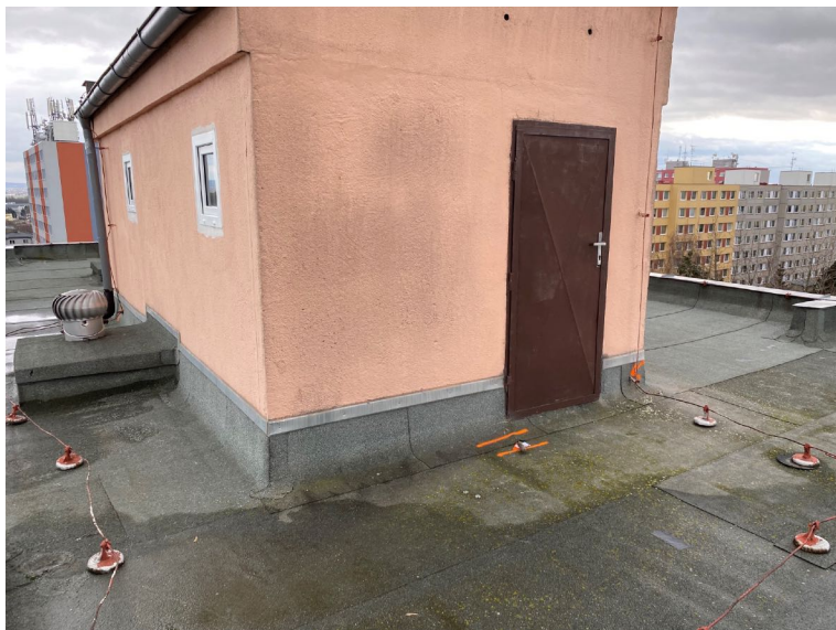
Obrázek 19: Projev dýmové zkoušky / příklad
