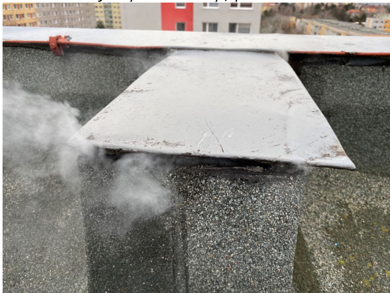
Obrázek 19: Projev dýmové zkoušky / příklad
