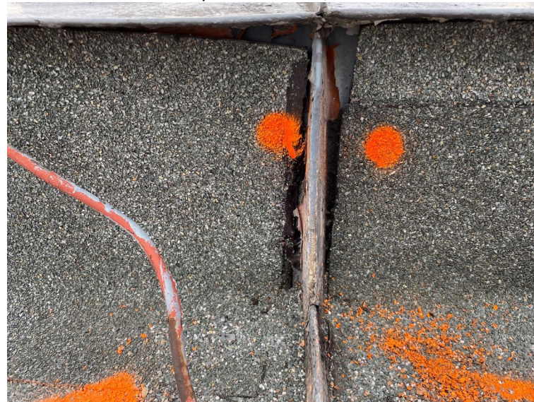
Obrázek 36: Vizuální nápadnost detail / dilatace
