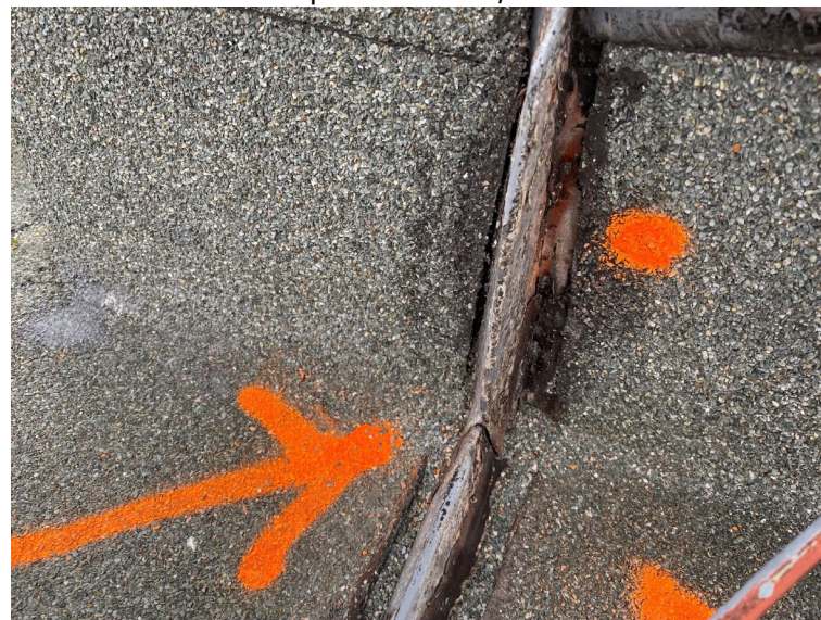
Obrázek 36: Vizuální nápadnost detail / dilatace
