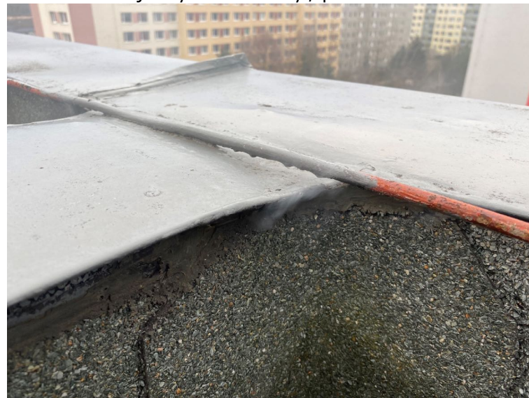
Obrázek 20: Projev dýmové zkoušky / příklad
