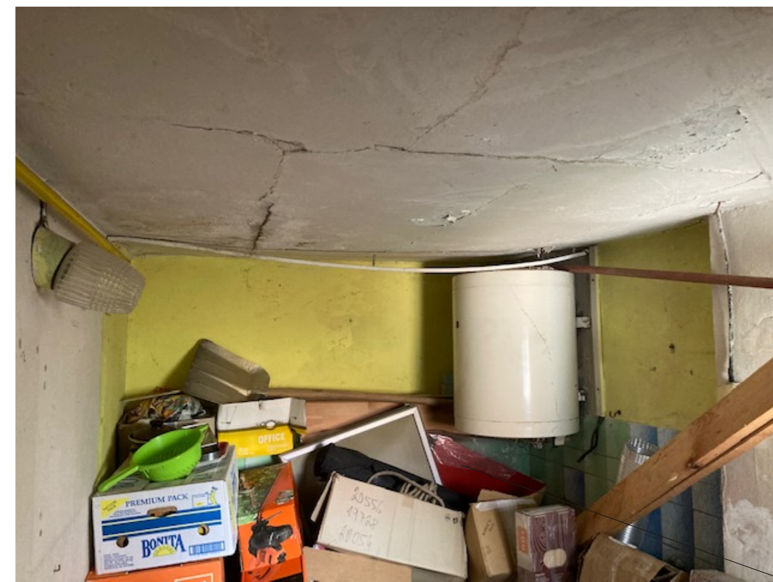
nový strop, vykosení interiéru staré koupelny
