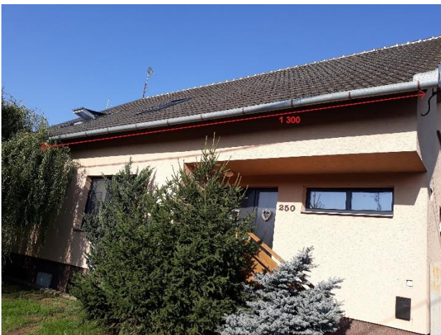
09-čelní strana domu (1 300)
