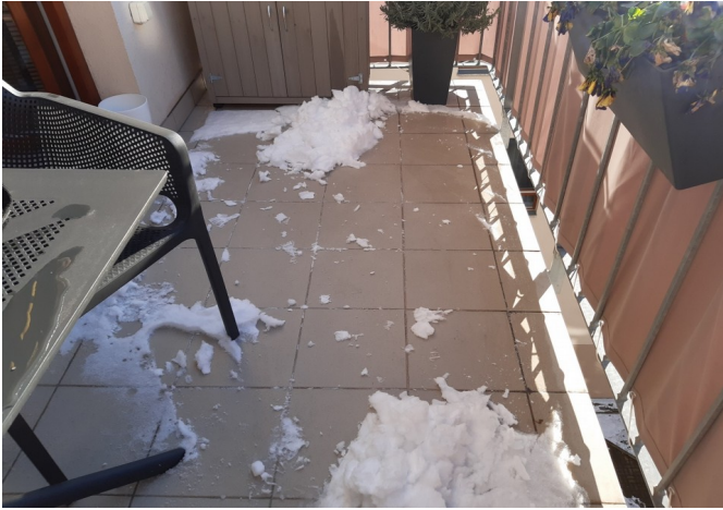
foto /4/ Pohled na balkon v bytové jednotce č. 451
