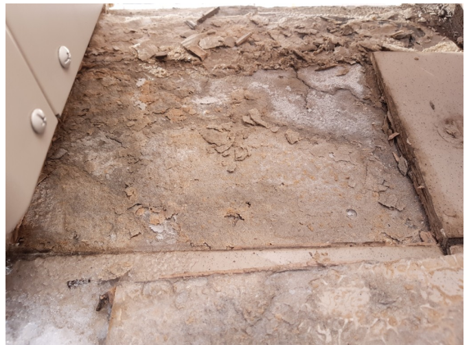
foto /7/ Místo demontáže nášlapné vrstvy
