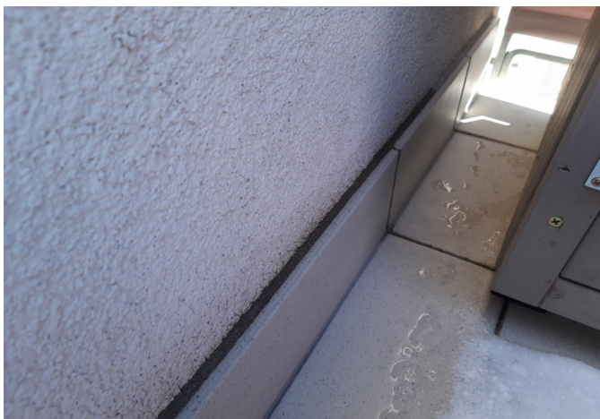
foto /12/ Sokl z přířezů keramické dlažby
