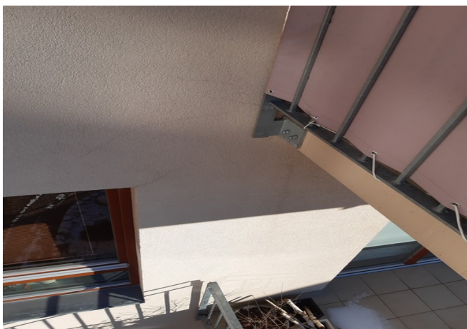
foto /14/ Kotvení zábradlí
