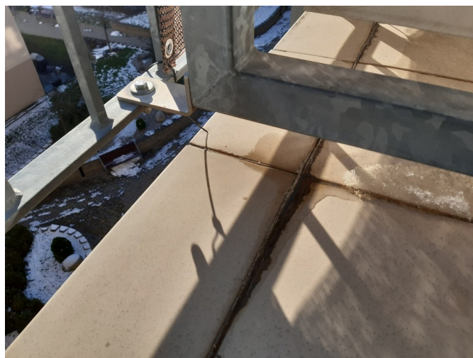
foto /9/ Degradace spárovací hmoty poblíž okapové hrany
