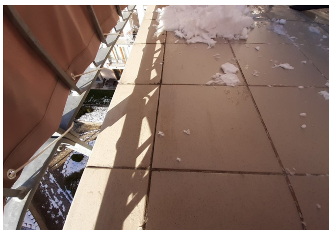
foto /10/ Odvodnění je řešeno pomocí okrajové dlaždice
