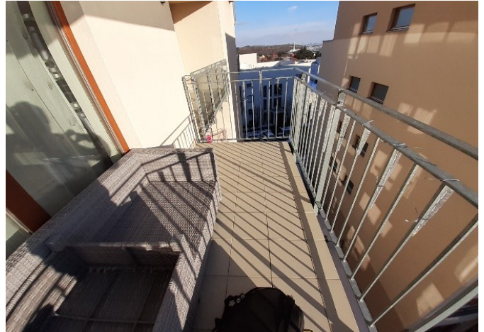
foto /5/ Pohled na balkon v bytové jednotce č. 352
