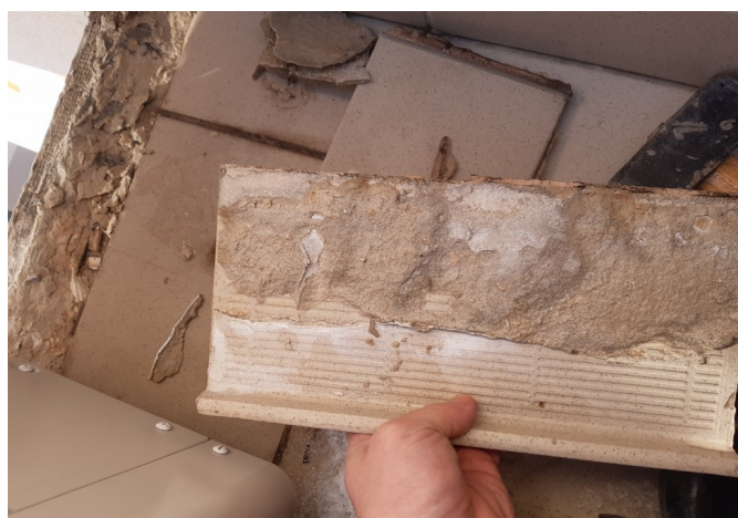
foto /11/ Okrajová dlaždice s okapovým nosem
