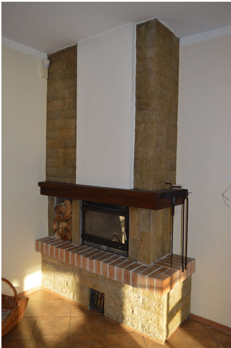
Demolice krbu – práce č. 16
