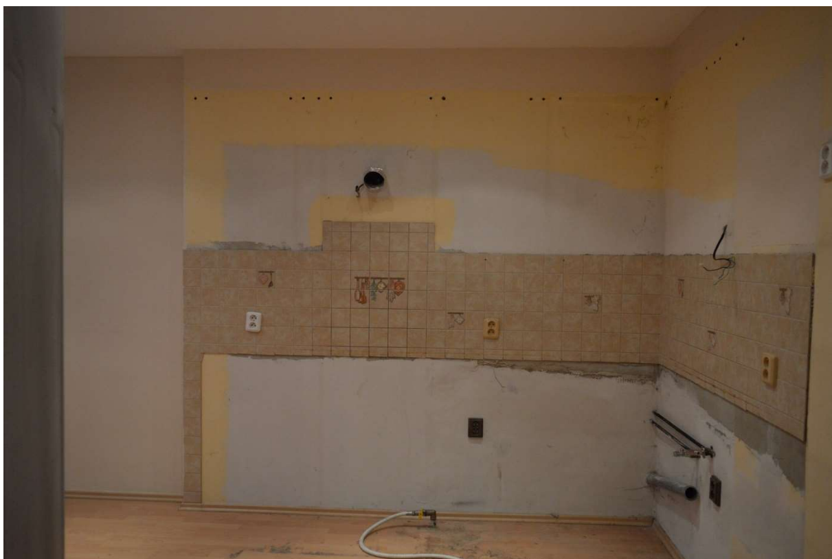
Foto bývalá kuchyň – práce 1+2+3
