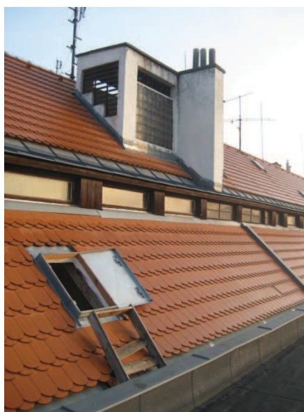
Obr. 4: Střecha A a střešní výlez na střechu B
