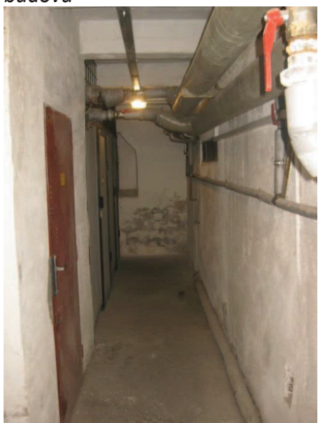
Obr. 113: Suterénní prostory objektu
