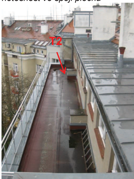
Obr. 67: Pohled na plochou střechu C1, místo provedené sondy T2
