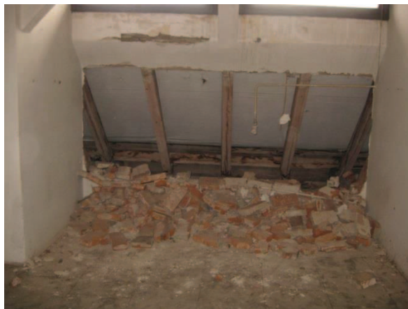
Obr. 36: Pohled na část podkroví (5.NP)
