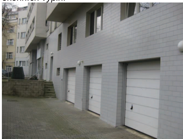
Obr. 98: Pohled na dvorní část přilehlou k objektu – vjezdy do garáží
