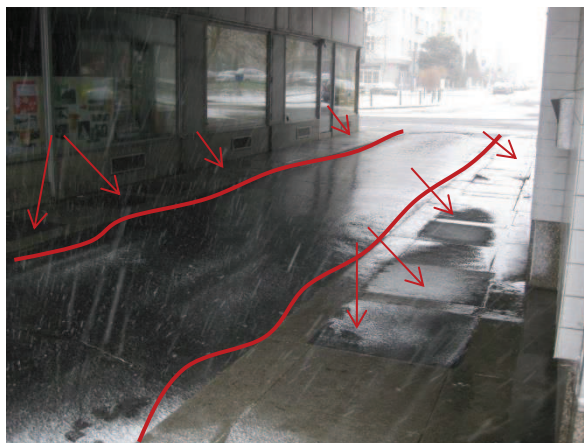
Obr. 112: Podsklepený průjezd vedoucí skrz budovu (místa zátoku vyznačena červeně)
