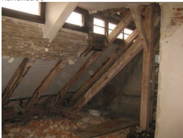
Obr. 35: Pohled na část podkroví (5.NP)
