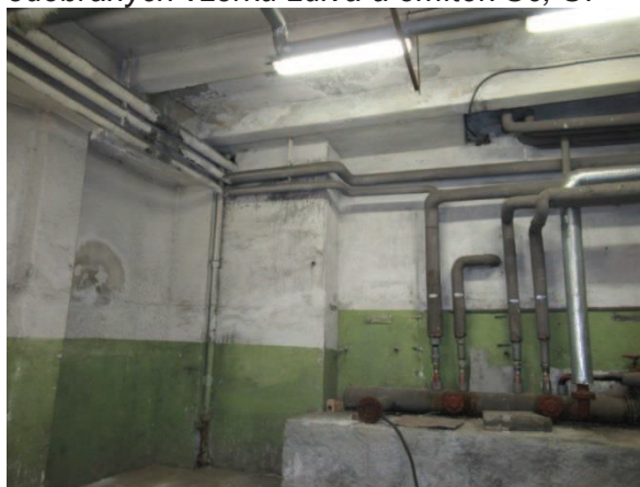
Obr. 120: Suterénní prostory objektu
