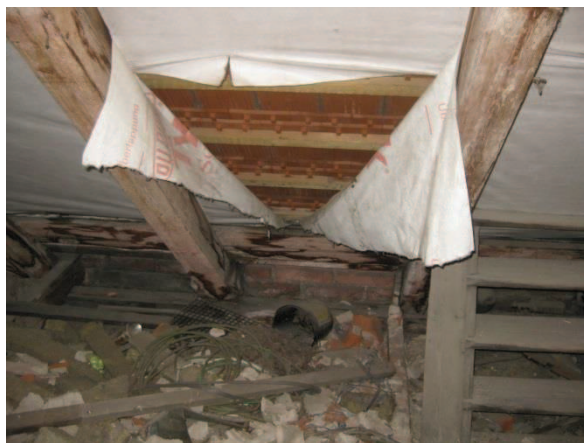
Obr. 38: Rozkrytá pojistná hydroizolační fólie
