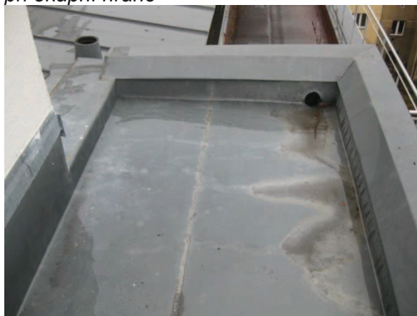
Obr. 24: Část střechy s plechovou krytinou nacházející se nad schodištěm
