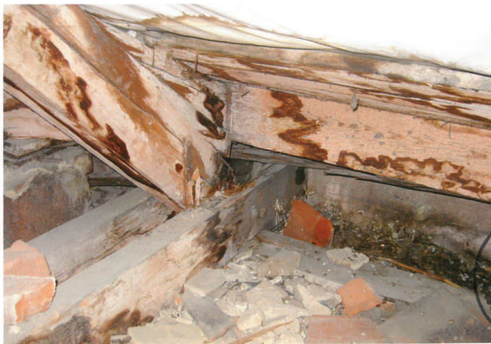
foto č. 7- poškození části pozednice, zhlaví krokve a zhlaví kleštiny hnědou hnilobou, sonda č.20
