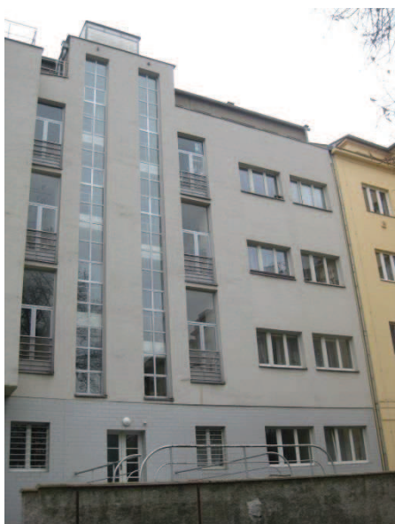
Obr. 91: Fasáda orientovaná do vnitrobloku
