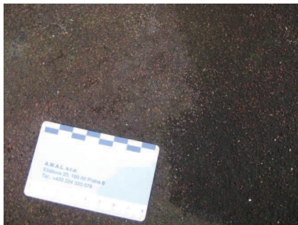
Obr. 72: Materiálový stav hydroizolace střechy C2
