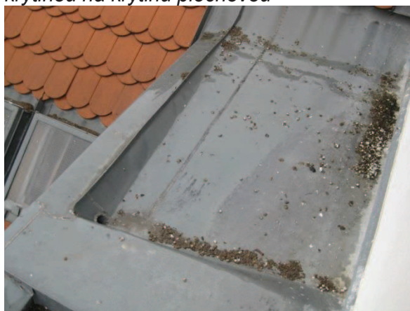
Obr. 18: Plechová krytina okolo nástavby strojovny výtahu
