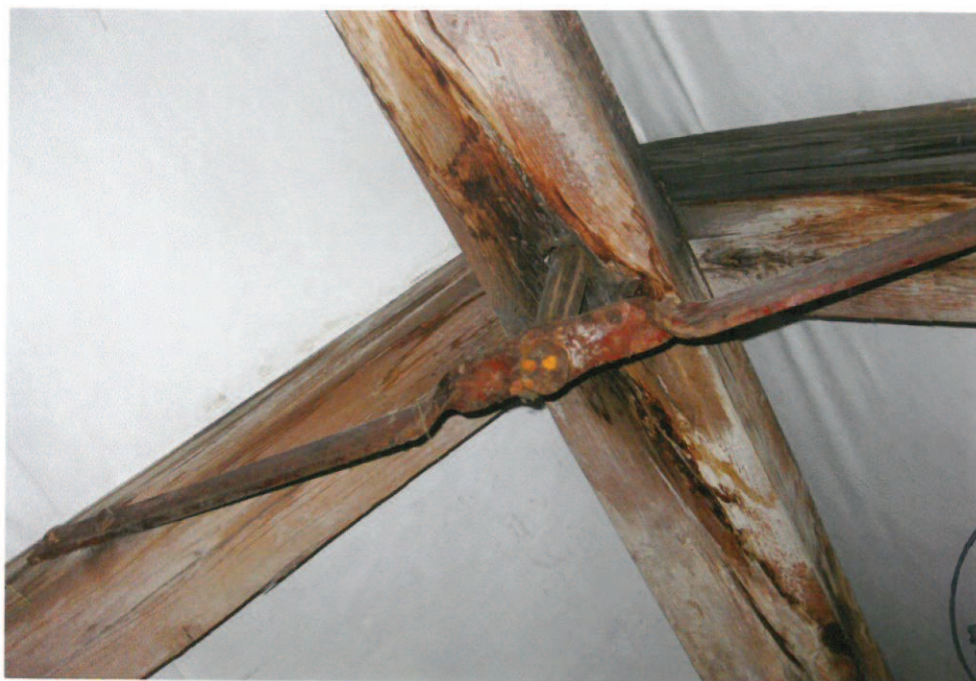
foto č. 9- v místě ukotvení tyče hromosvodu vaznice poškozena hnědou hnilobou, sonda č. 28
