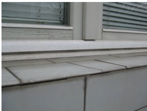
Obr. 86: Detail parapetu, dožilá spárovací hmota obkladu
