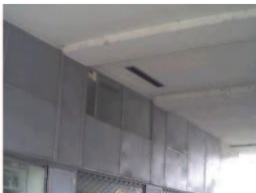
Obr. 143: Pohled část průjezdu a přilehlé konstrukce
