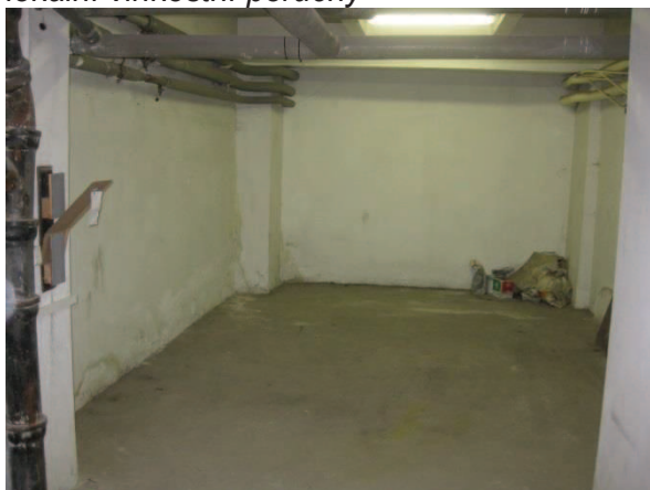
Obr. 119: Suterénní prostory objektu
