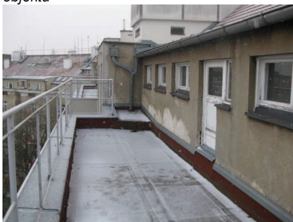
Obr. 99: Pohled na část fasády do vnitrobloku – vikýř v 5.NP
