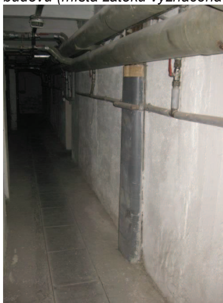
Obr. 114: Suterénní prostory objektu
