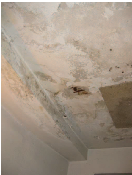
Obr. 123: Stav železobetonové stropní konstrukce pod vstupem Zelená 14
