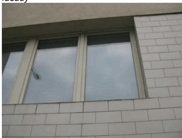
Obr. 94: Detail parapetu, dožilá spárovací hmota obkladu
