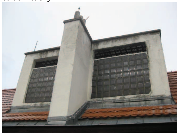
Obr. 9: Střešní nástavba a ukončení světlíku
