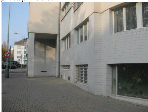
Obr. 82: Pohled na část průčelí, soklová část
