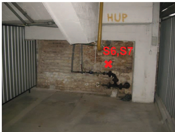
Obr. 118: Suterénní prostory objektu, místa odebraných vzorků zdiva a omítek S6, S7
