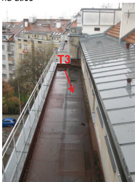
Obr. 68: Pohled na plochou střechu C2, místo provedené sondy T3
