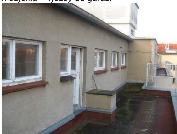
Obr. 100: Pohled na část fasády do vnitrobloku – vikýř v 5.NP
