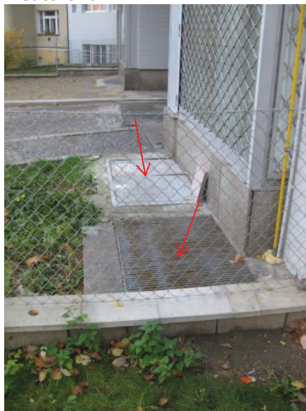
Obr. 126: Anglický dvorek a výtahová šachta ze strany vnitrobloku
