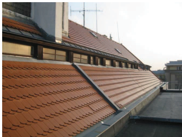
Obr. 3: Pohled na sedlovou střechu A s pálenou krytinou
