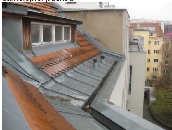
Obr. 15: Pohled na část střechy A orientované do vnitrobloku
