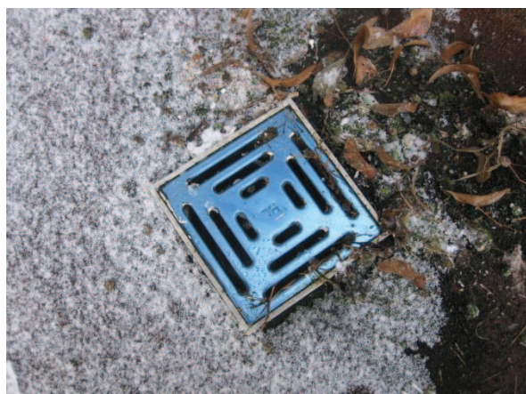
Obr. 75: Střešní vpust – odvodnění střechy C2
