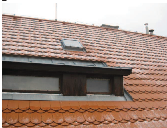
Obr. 6: Část vikýře v sedlové střechě
