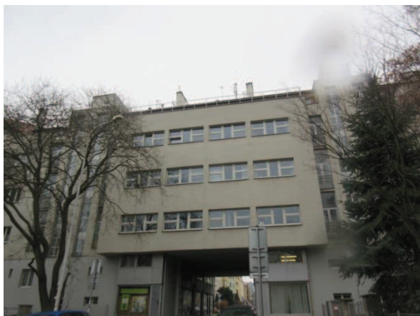
Obr. 89: Fasáda orientovaná do vnitrobloku
