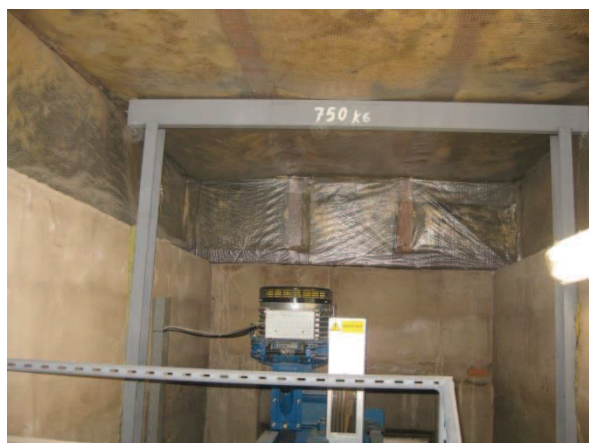
Obr. 49: Pohled do interiéru strojovny výtahu
