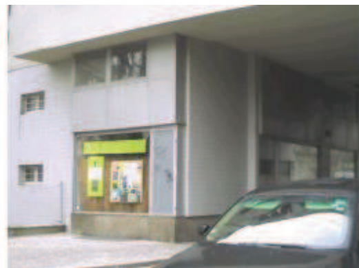
Obr. 141: Pohled část průjezdu a přilehlé konstrukce
