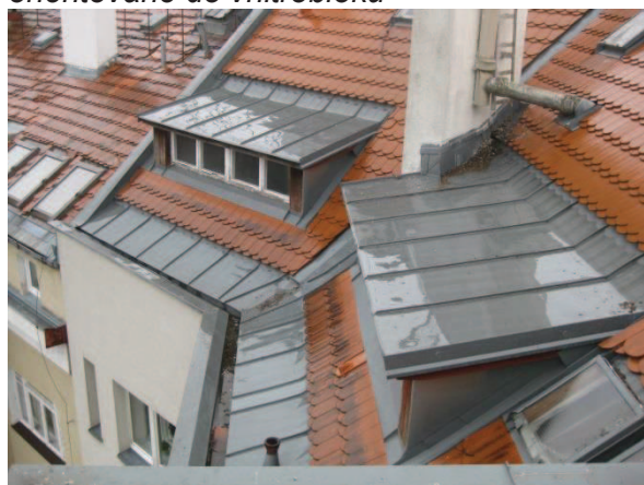
Obr. 17: Pohled na část střechy A orientované do vnitrobloku
