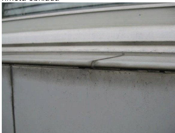
Obr. 88: Detail parapetu, dožilá spárovací hmota obkladu
