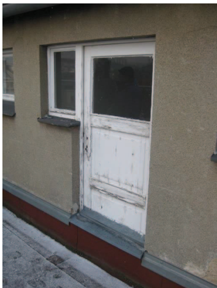
Obr. 105: Oprýskané výplně otvorů, absence kování dveří
