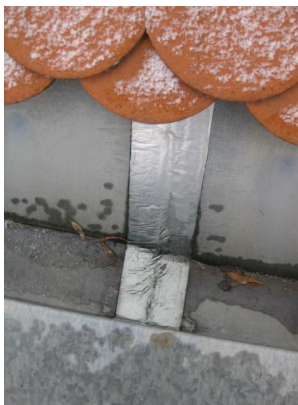
Obr. 14: Spoje žlabu přelepené samolepící páskou
