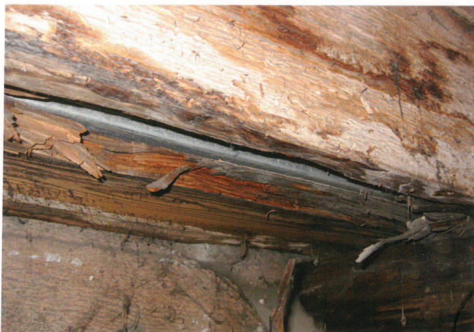
foto č. 3- dno koryta poškozené hnědou hnilobou, sonda č. 16
