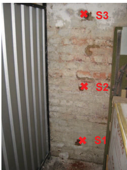
Obr. 115: Sklepní kóje, místa odebraných vzorků zdiva S1, S2, S3
