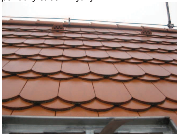
Obr. 10: Větrací střešní tašky u hřebene
