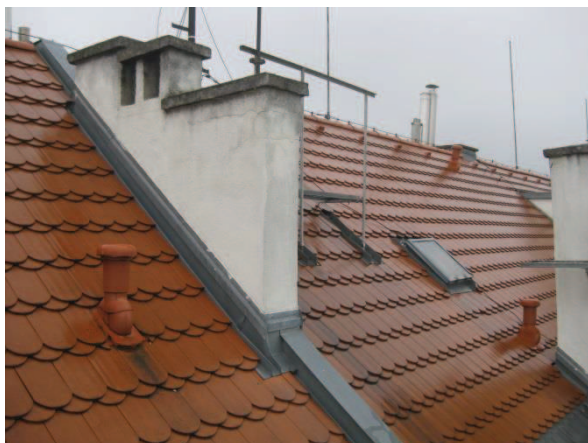
Obr. 19: Pohled na část střechy A orientované do vnitrobloku
