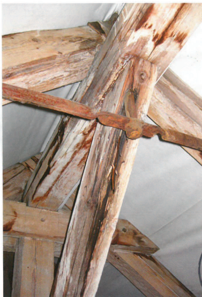
foto č. 7- poškození části pozednice, zhlaví krokve a zhlaví kleštiny hnědou hnilobou, sonda č.20
