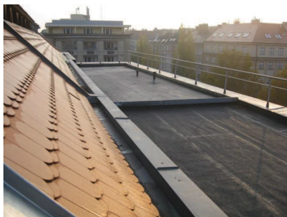
Obr. 51: Pohled na plochou střechu B
