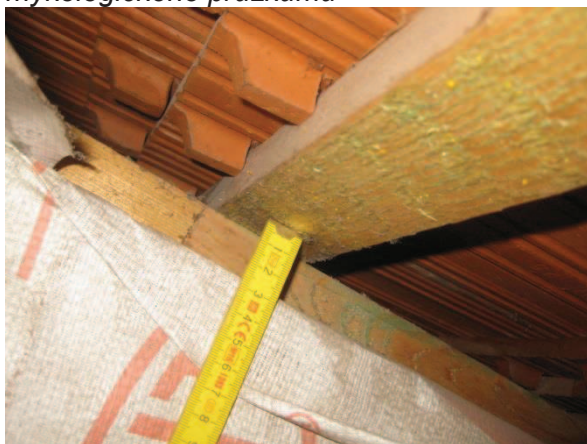
Obr. 39: Tloušťka provětrávané mezery (<30 mm) vymezené kontratatěmi
