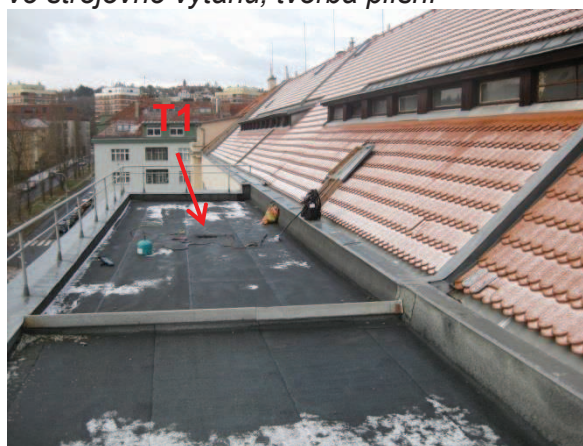
Obr. 52: Pohled na plochou střechu B, místo provedené sondy T1
