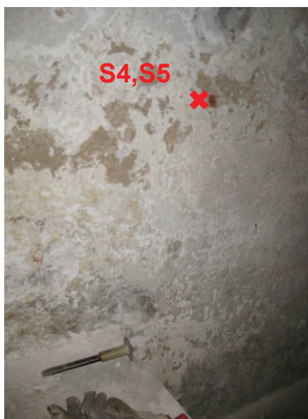
Obr. 116: Suterénní prostory objektu a místa odebraných vzorků zdiva a omítek S4, S5
