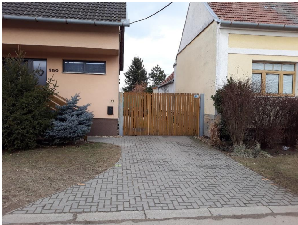
Pohled k bráně a vjezdu z vnější strany (z ulice).
