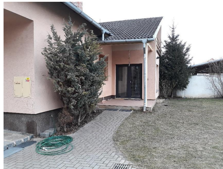
Navazující pravá část domu – prostor.
