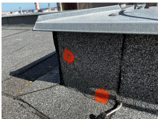
Obr. /22/ Separace tavných spojů
