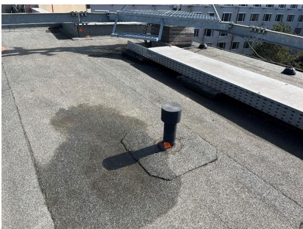
Obr. /13/ Prostup odvětrání
