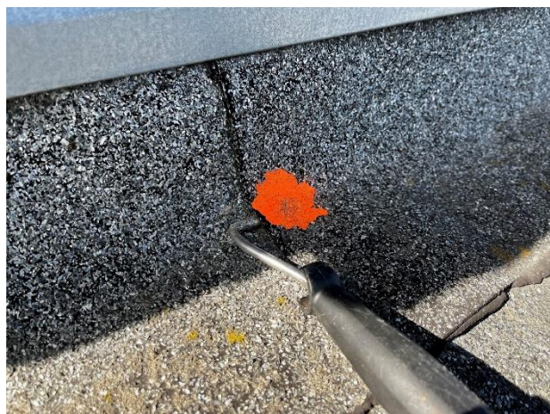
Obr. /26/ Separace tavných spojů
