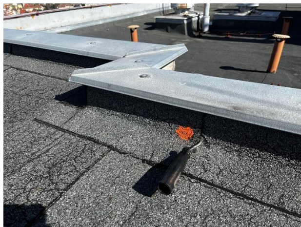
Obr. /24/ Separace tavných spojů
