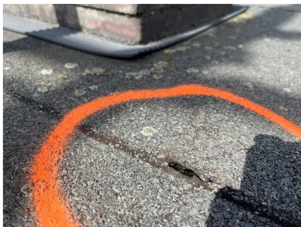
Obr. /20/ Separace tavných spojů
