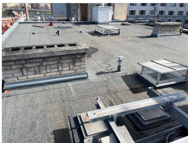
Obr. /4/ Pohled na střešní plášť
