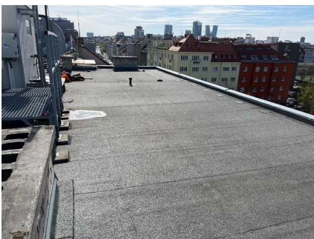
Obr. /3/ Pohled na střešní plášť
