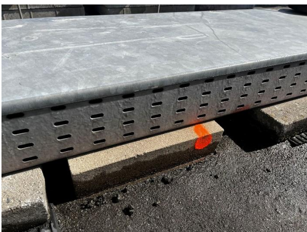
Obr. /36/ Chybějící podložky
