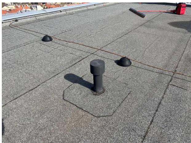
Obr. /12/ Prostup odvětrání
