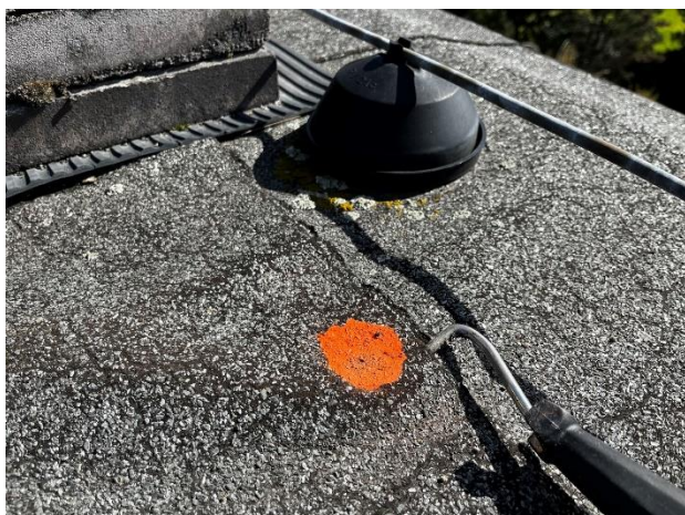
Obr. /25/ Separace tavných spojů
