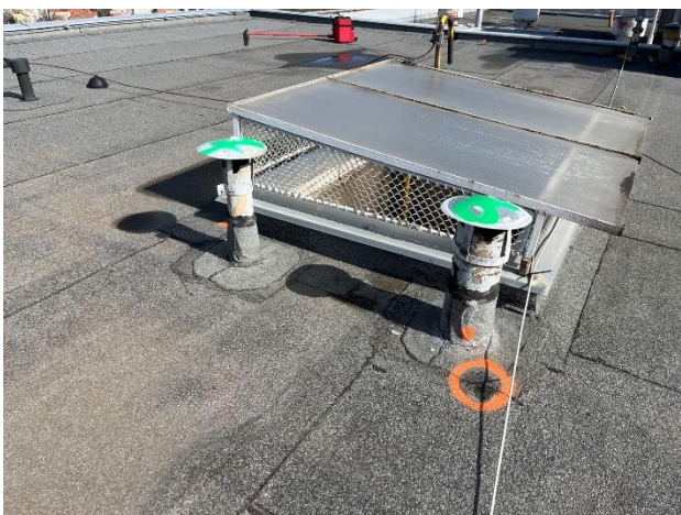
Obr. /11/ Prostup odvětrání
