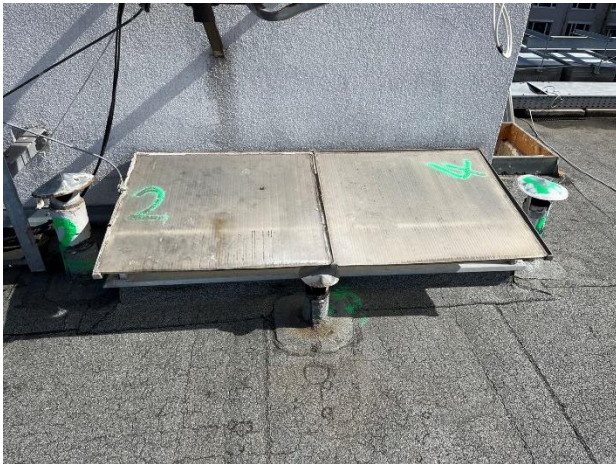
Obr. /15/ Prostup odvětrání
