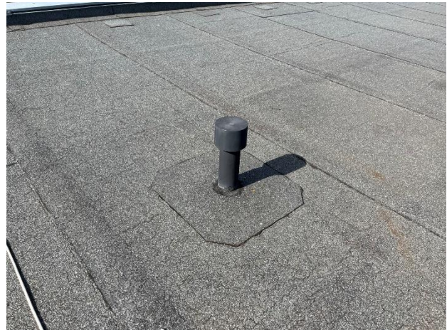
Obr. /16/ Prostup odvětrání
