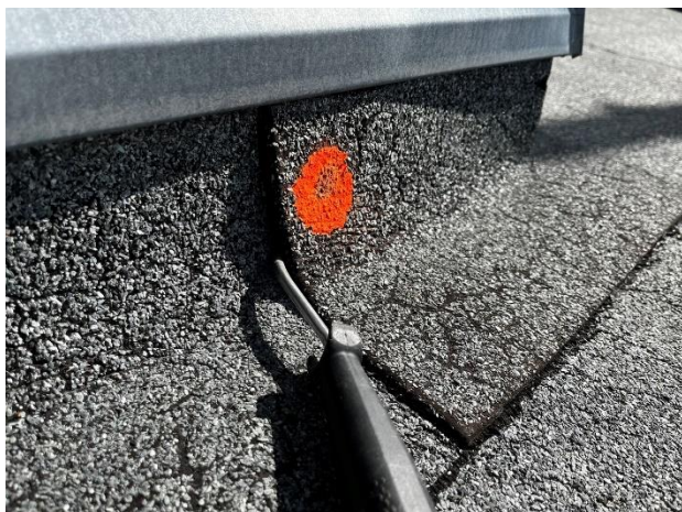
Obr. /23/ Separace tavných spojů
