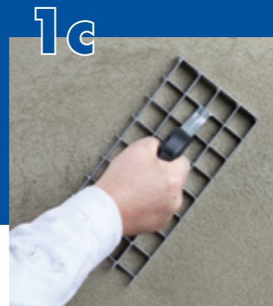
1c Oškrábání povrchu po ztuhnutí omítky a srovnání případných nerovností.
