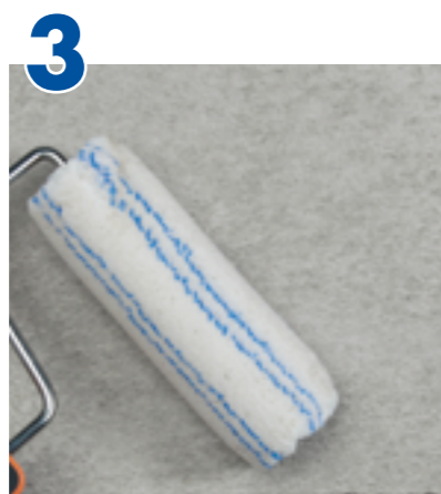
3 Provedení základního penetračního nátěru pro snížení a sjednocení nasákavosti podkladu.
