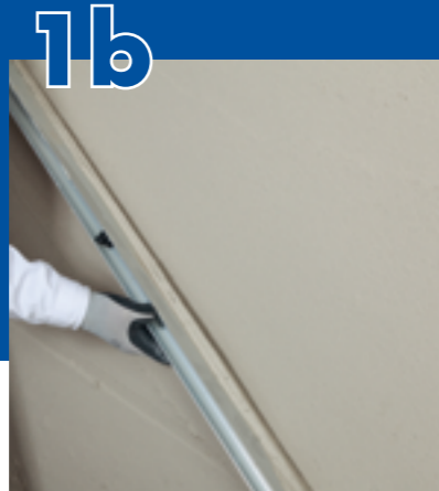
1b Srovnání omítkové vrstvy trapézovou latí.
