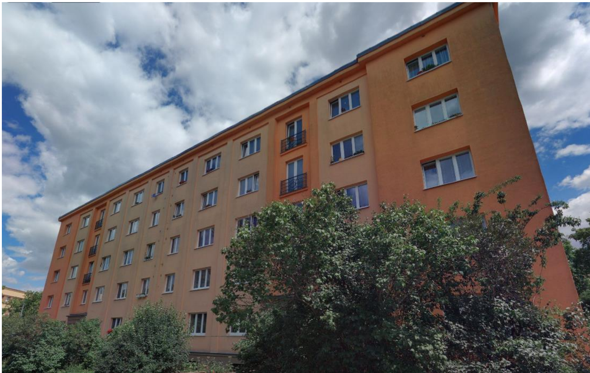
Západní strana - ošetření pouze části fasády s okny, plocha nadpraží a ostění otvorů 52 m 2 , plocha fasády 450 m 2 , ostatní již čištěno. Sokl (55 m 2 ) pouze omytí tlakovou vodou, bez potřeby ochranného nátěru.
