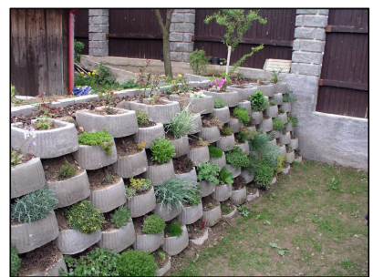
OPĚRKA ZE SVAHOVÝCH TVÁRNIC
