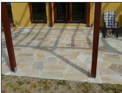
KAMENNÁ DLAŽBA – VARIANTA "DO BETONU"
