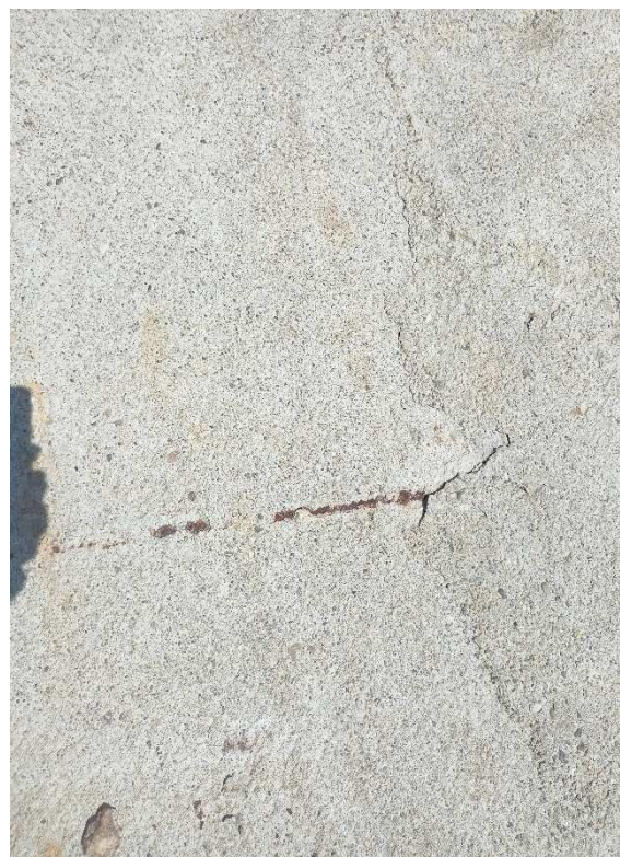
24 Trhliny na kopule z vonkajšej strany
