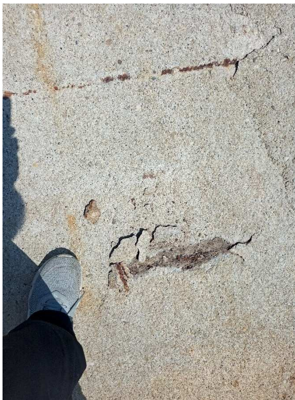
23 Trhliny na kopule z vonkajšej strany
