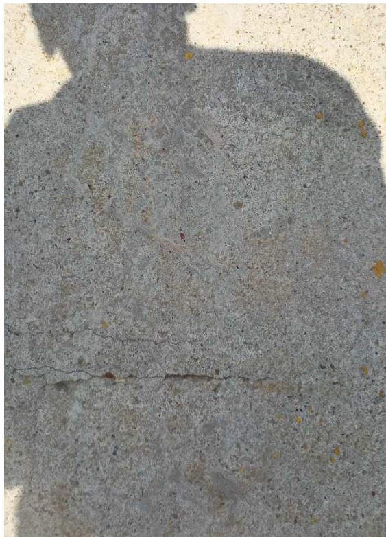
26 Trhliny na kopule z vonkajšej strany
