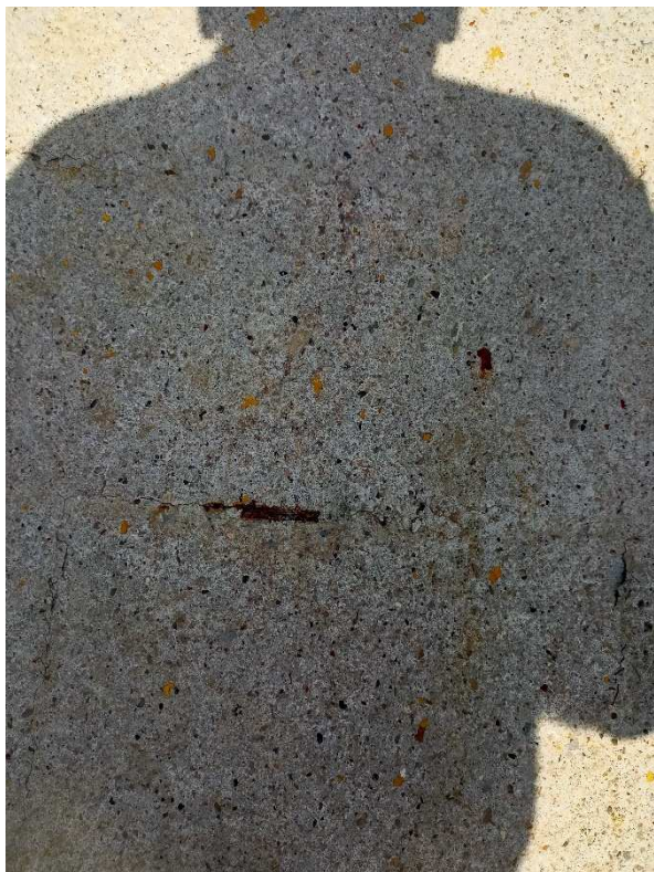
25 Trhliny na kopule z vonkajšej strany
