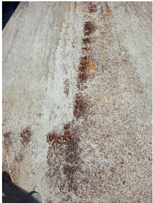
30 Poškodený betón na kopule pod lávkou
