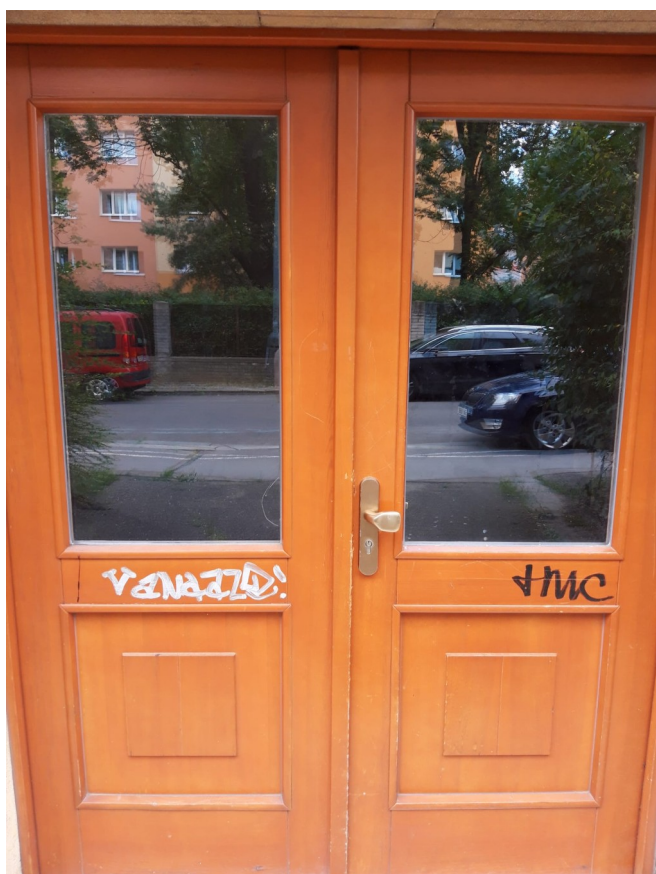
2/ Renovační nátěr dřevěných dveří (prosím, vizte obr.)
