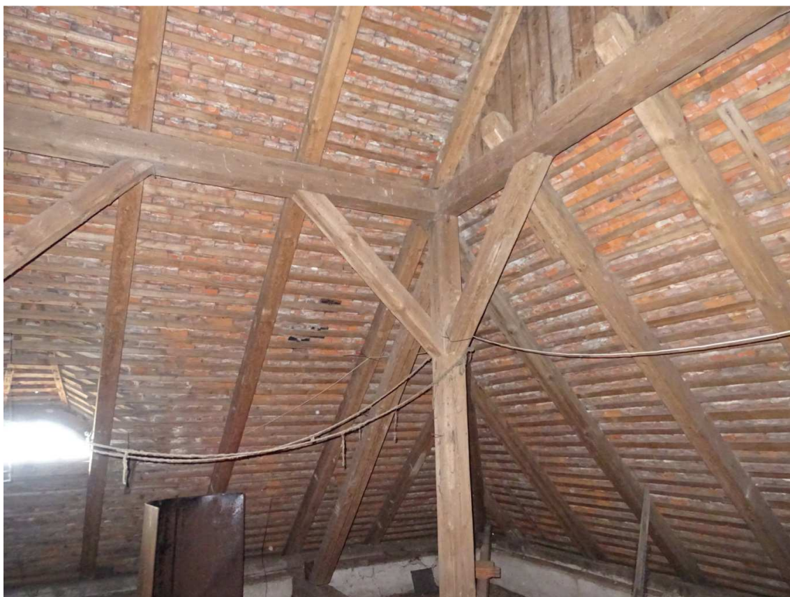
Pohled do interiéru stávajícího krovu na rohový sloupek
