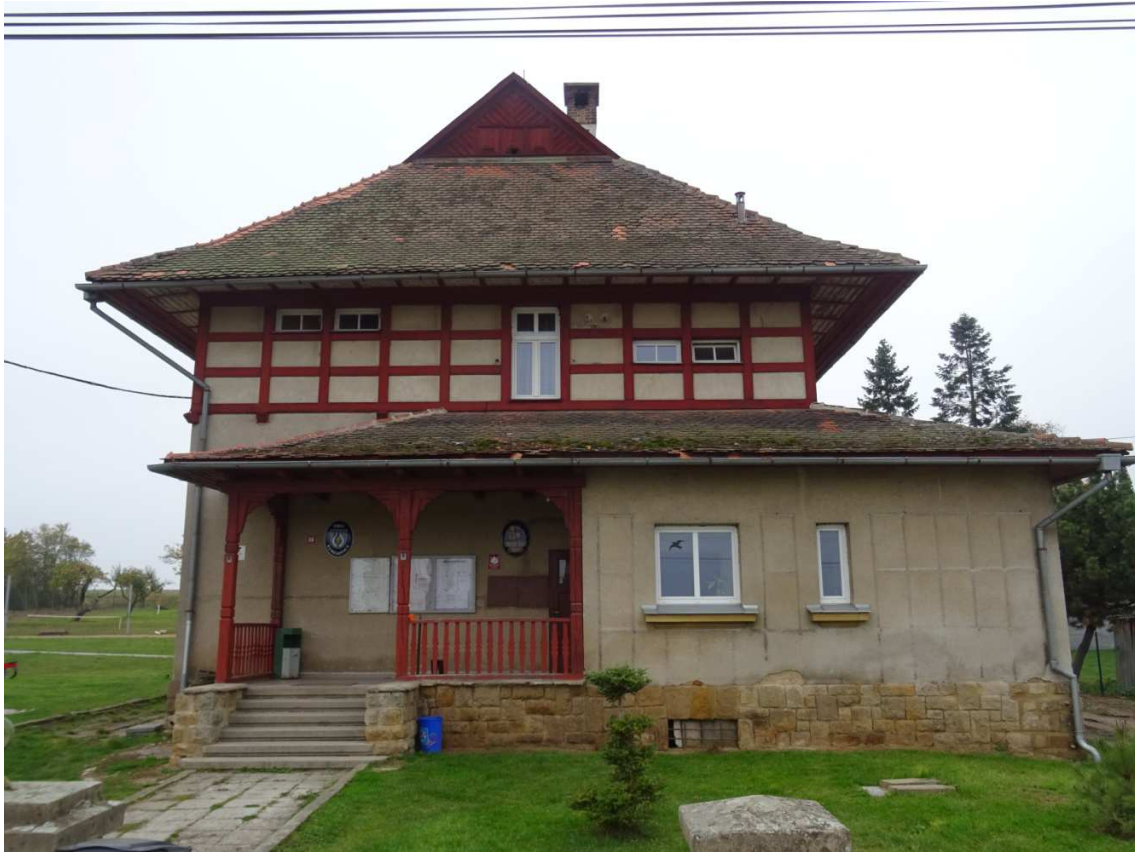
Východní fasáda objektu
