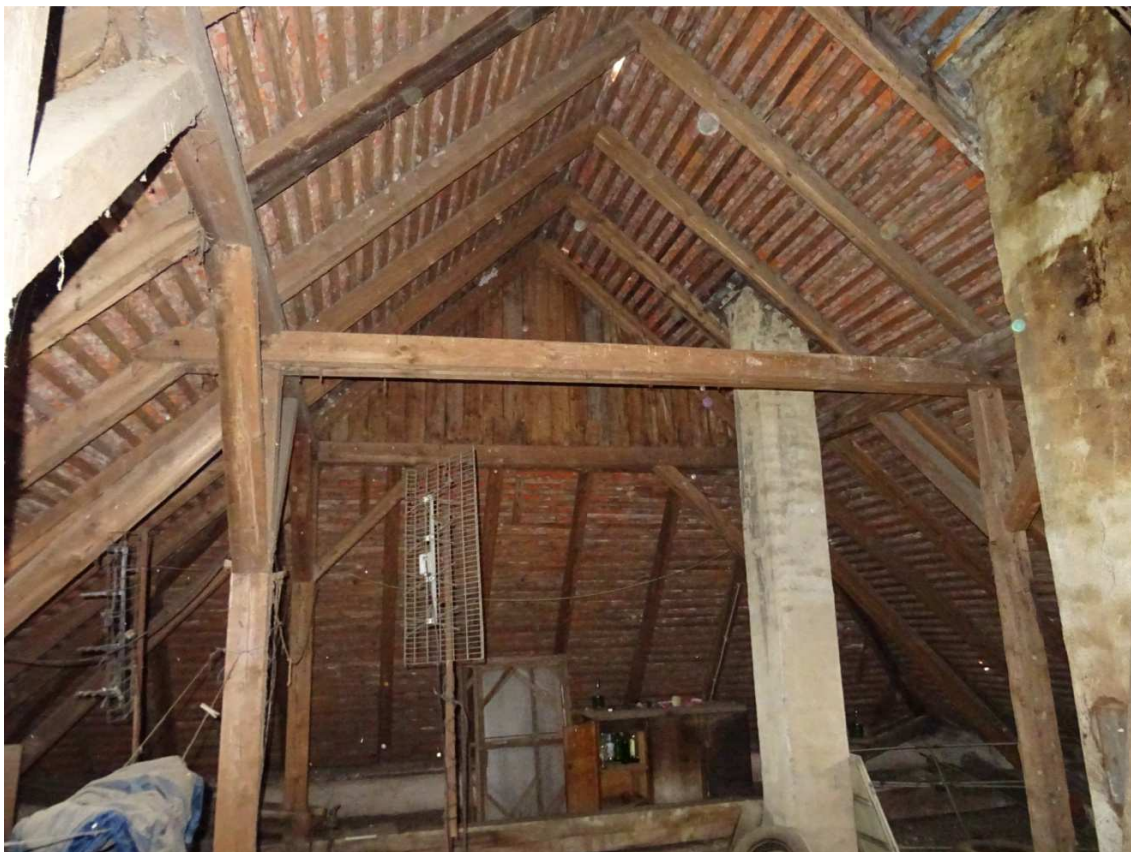
Západní strana, pohled do interiéru stávajícího krovu
