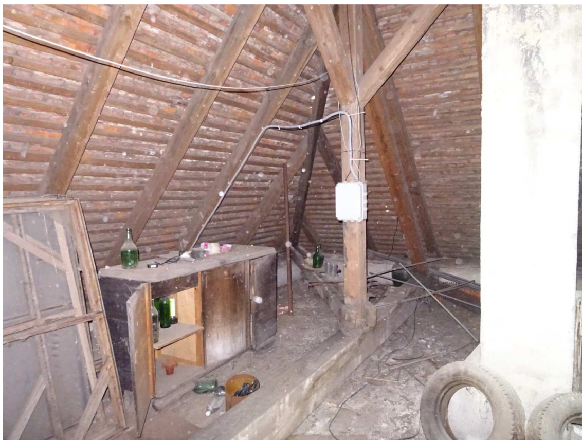
Pohled do interiéru stávajícího krovu na nárožní krokev
