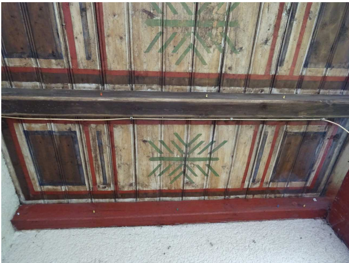
Detail dřevěného stropního trámu a podbití vstupní verandy
