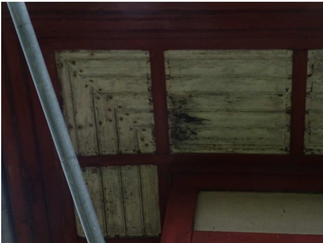
Detail dřevěného podbití hlavní střechy objektu
