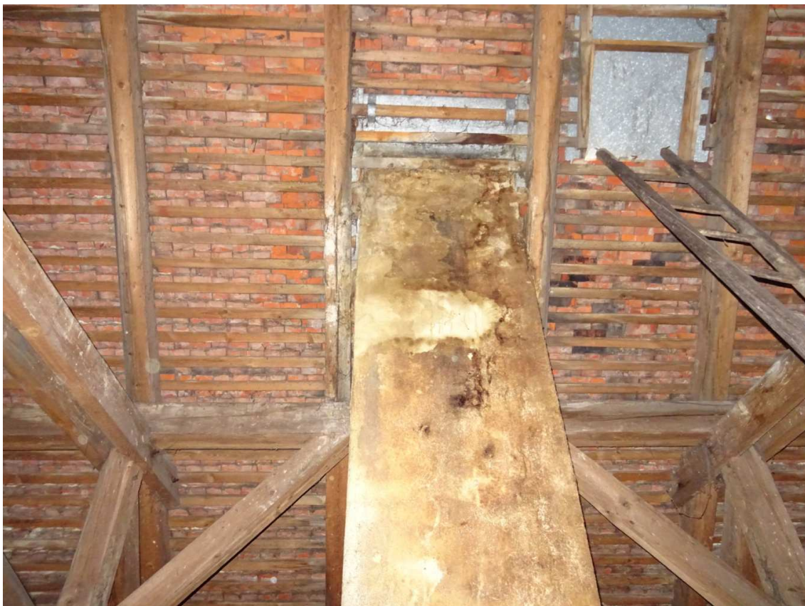
Pohled do interiéru stávajícího krovu na komínové těleso a poklop
