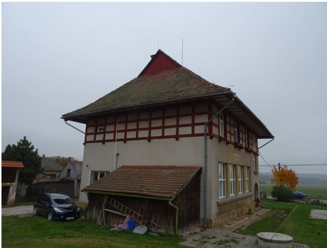
Západní fasáda budovy
