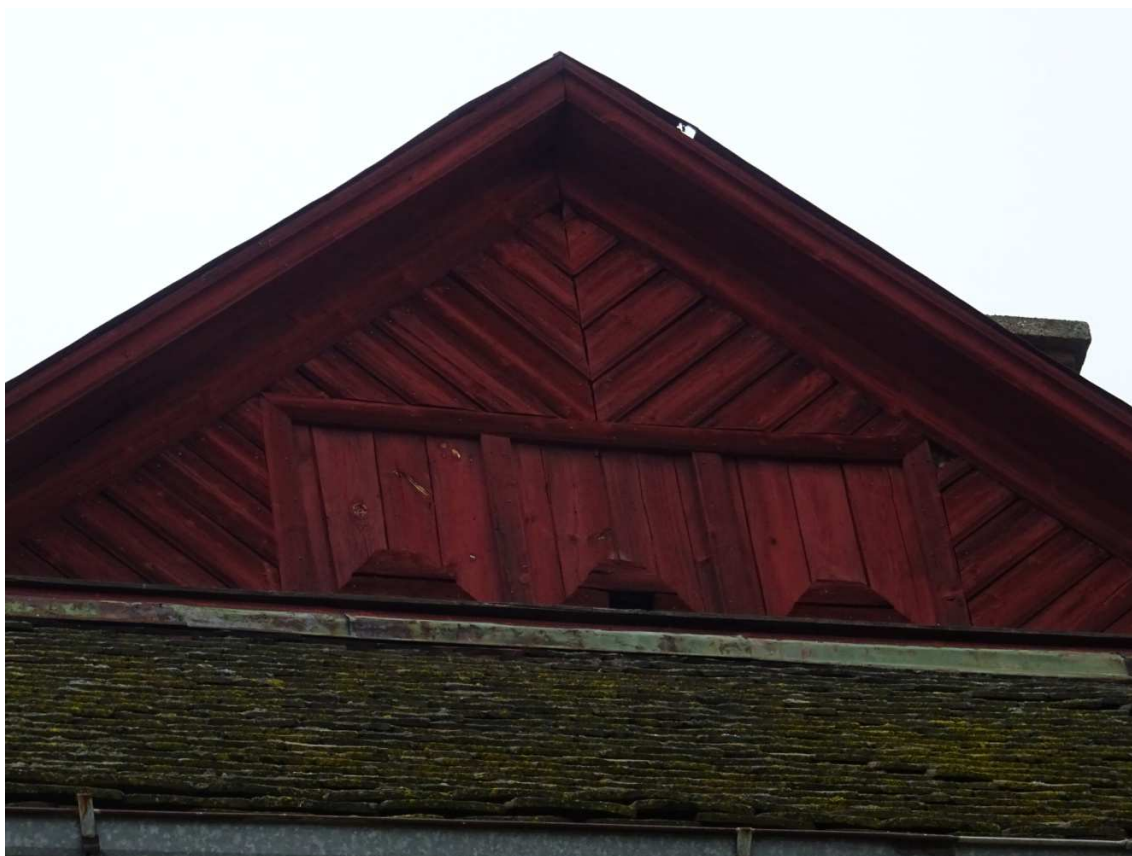
Detail dřevěného štítu na východní straně objektu
