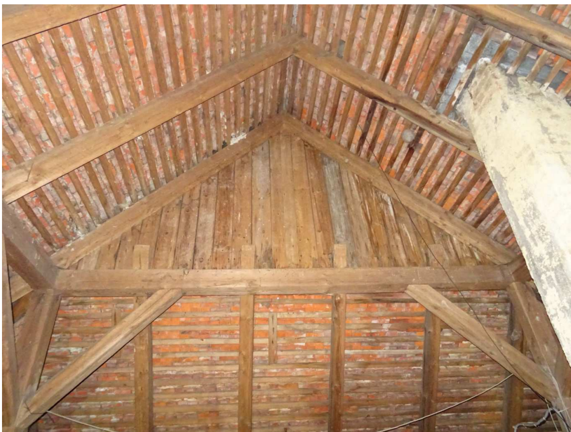
Západní štít z interiéru krovu
