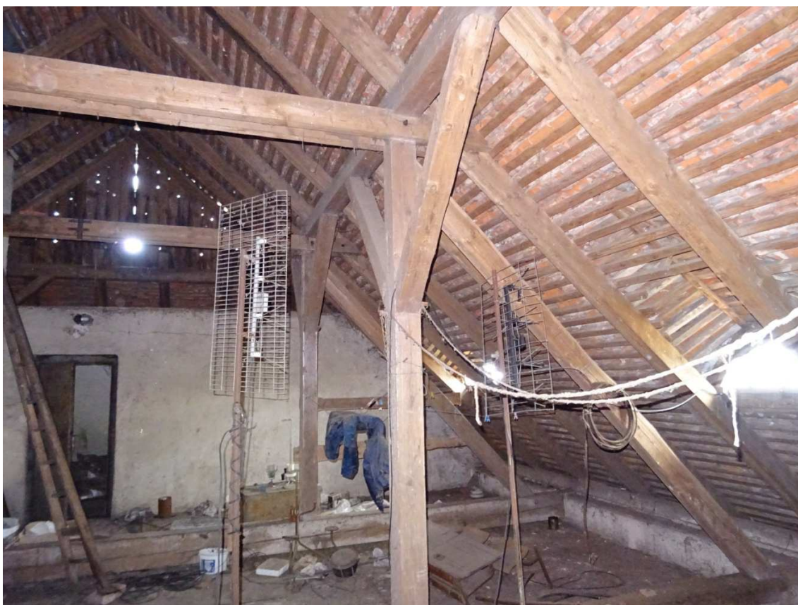
Jižní stran, pohled do interiéru stávajícího krovu
