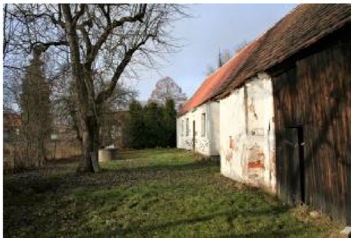
05 obytná část stávajícího domu a zahrada se studnou
