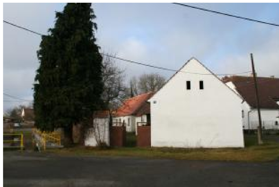
10 pohled z návsi na východní štít hospodářské části domu s vjezdem na pozemek
