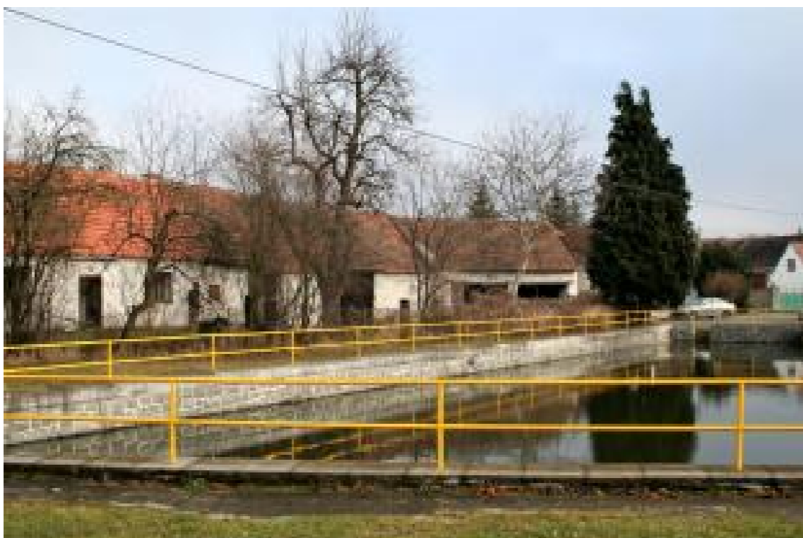
01 pohled z návsi přes požární nádrž
