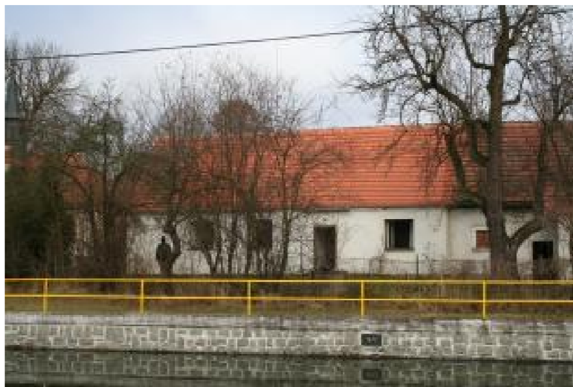
02 pohled z návsi přes požární nádrž
