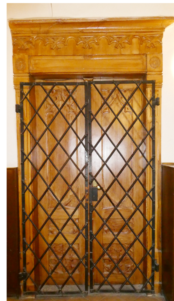
FOTO STÁVAJÍCÍCH DVOUKRIDLÝCH DVEŘÍ POHLED Z DOMOVNÍ CHOUBY NOVÉ DVEŘE BUDOU V OBDOBNÉM PROVEDENÍ
