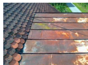
Oplechování střechy západní mansardy
