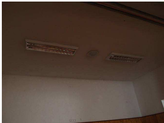
Obr.: Svietidlá s lineárnymi žiarivkami
