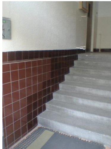
Pohľad na schodisko - miesto na umiestnenie madla.
