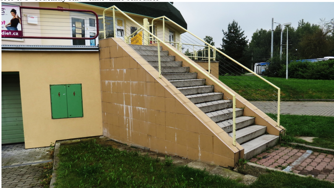
foto č. 4 - současný stav venkovního schodiště
