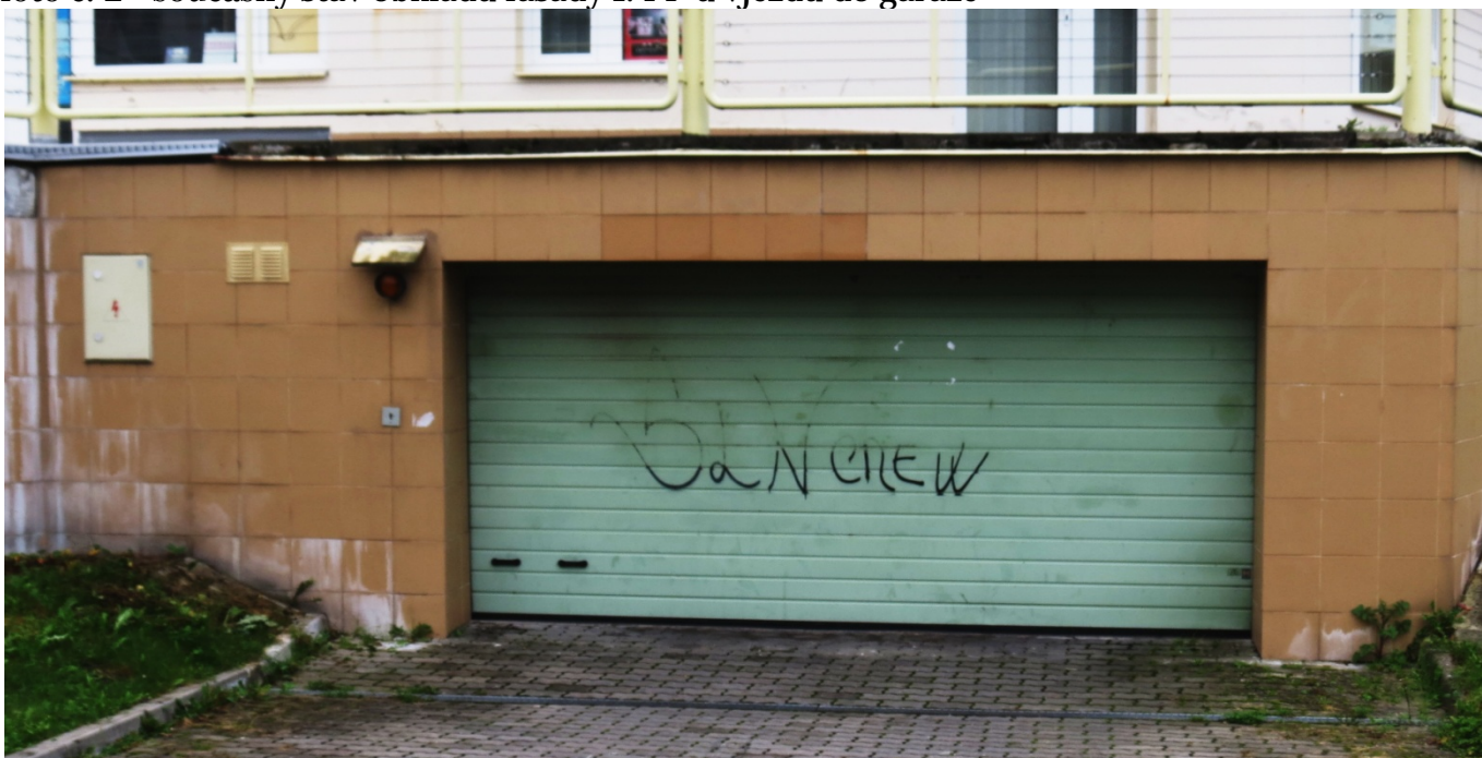
foto č. 2 - současný stav obkladu fasády I. PP u vjezdu do garáže
