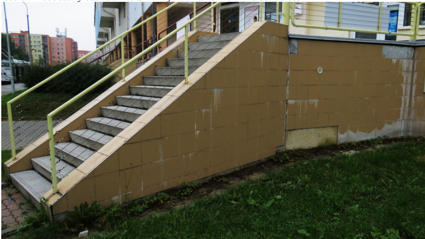
foto č. 1 - současný stav obkladu fasády I. PP a venkovního schodiště
