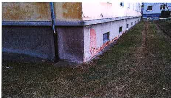
Zadní strana budovy (problémové místa ukotvení nopové folie)
