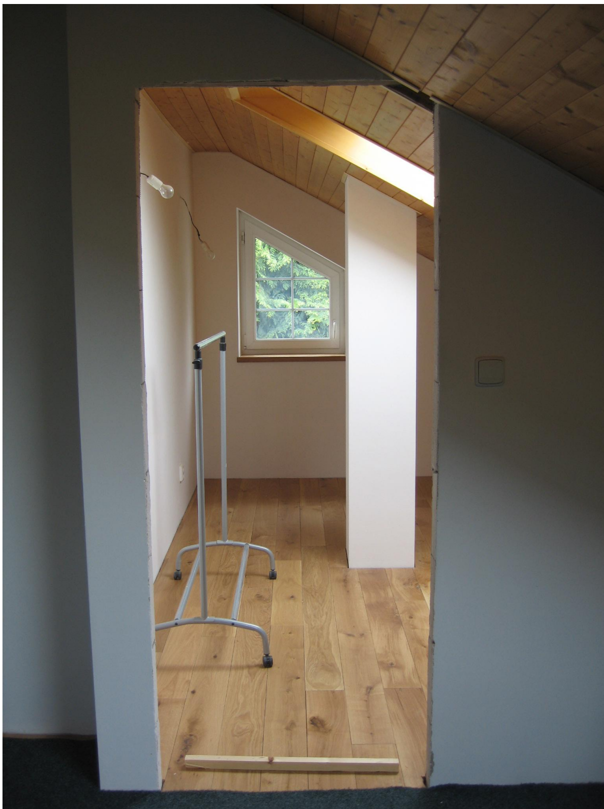
Dveře II Šířka 800 mm (nahore po odečtení zkosení – 690 mm) Tloušťka 80 mm Výška 2015 mm (vpravo po odečtení zkosení – 1950 mm) (délka zkosení vpravo nahore 130 mm)
