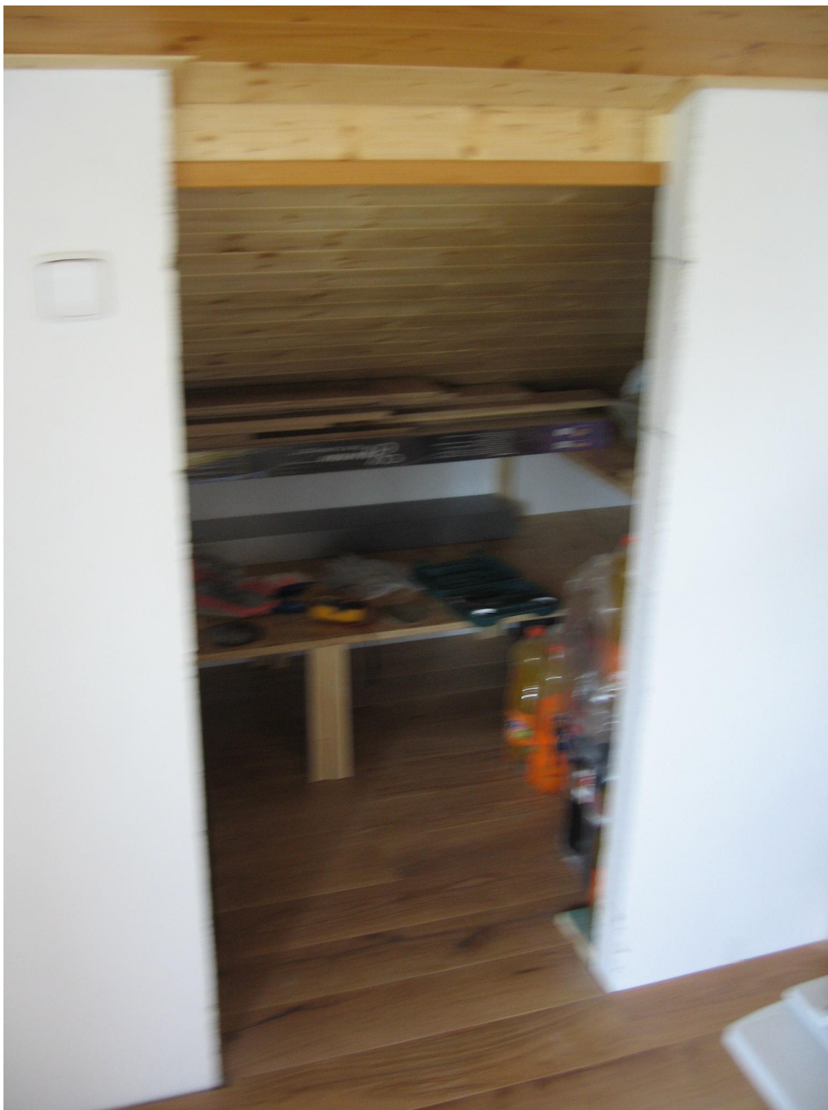
Dvířka I Šířka 710 mm Tloušťka 80 mm Výška – zadní strana 1355 mm, po začátek zkosení 1450 mm, přední strana 1485 mm
