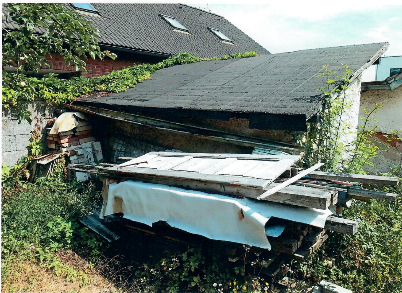
veľkú časť sled a sudový záchod - pohľad od západu
