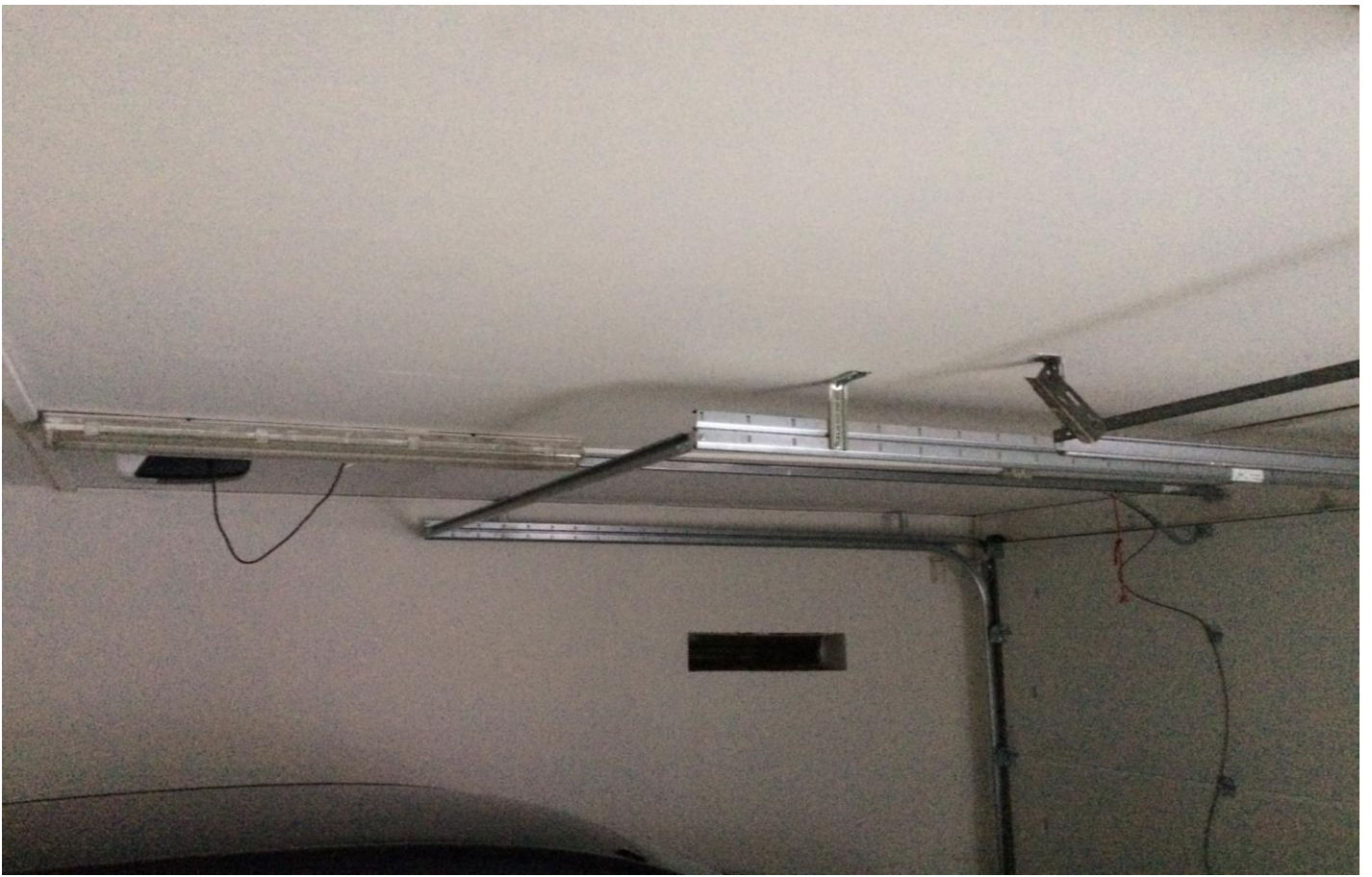
Pohled na upevnění konstrukce pátých již vyměněných vrat
