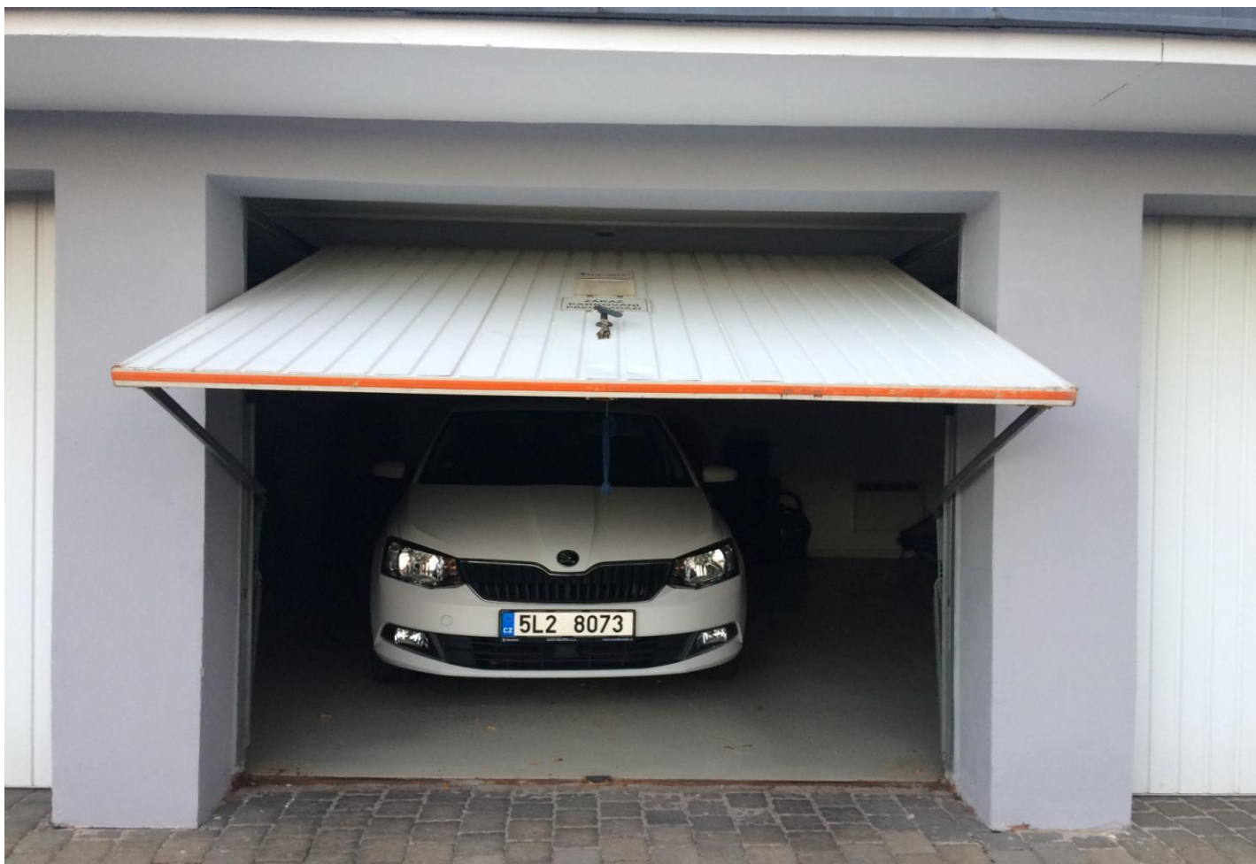
Orientační pohled na vrata stávající
