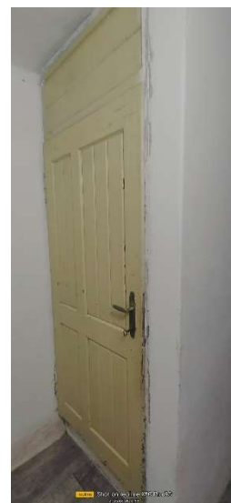
vstupní dveře na schodiště
