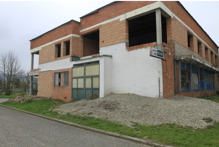
VÝCHODNÍ STRANA BUDOVY
