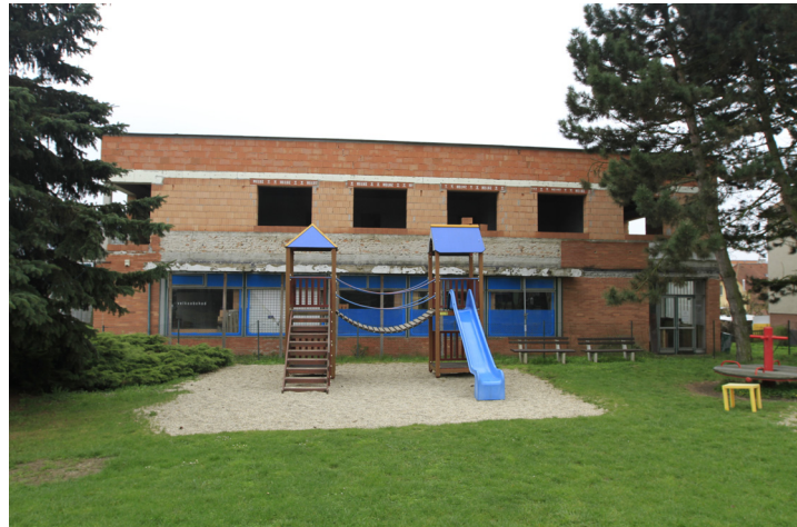
SEVERNÍ STRANA BUDOVY
