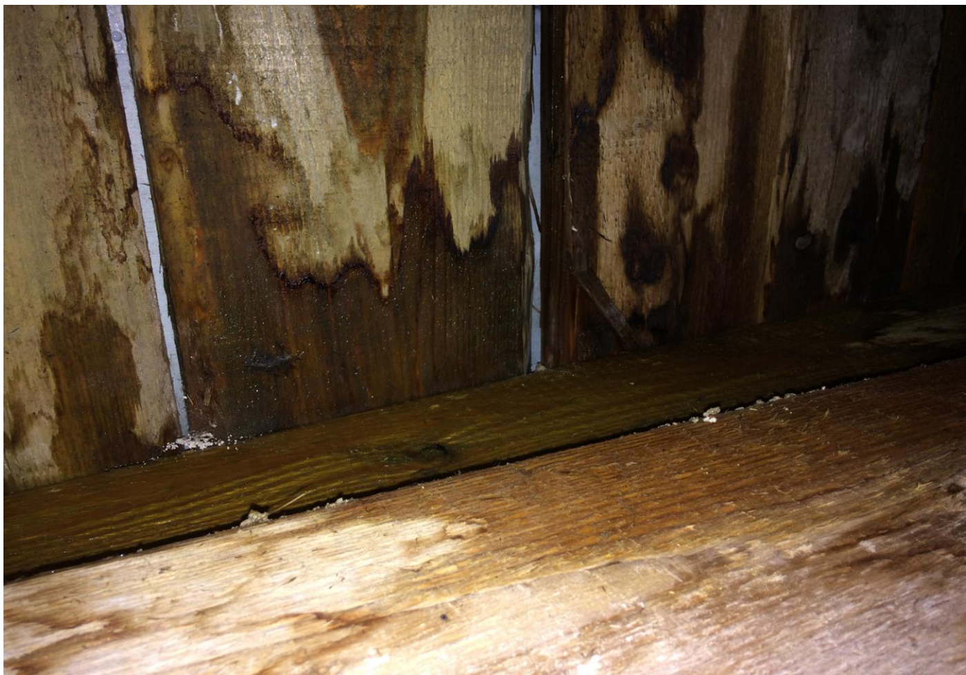
Prostor nad podhledem - konstrukce krovu (mezi prkny je vidět materiál krytiny)
