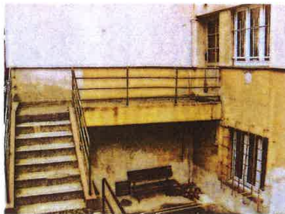
Vchod do objektu ze dvora.
