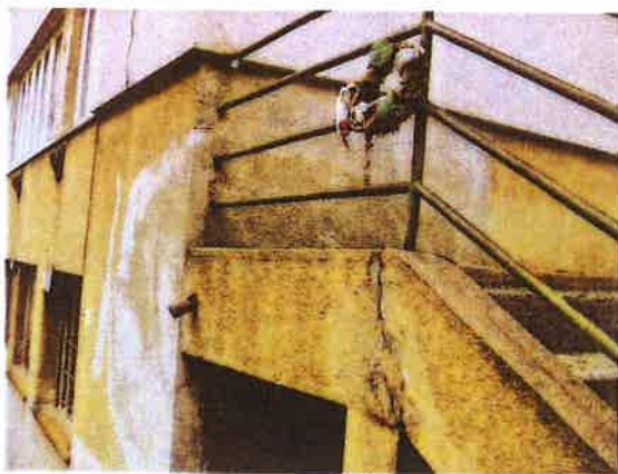
Odvodnění podesty schodiště pomocí chrliče.
