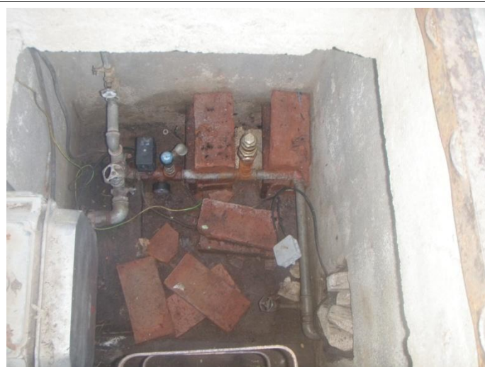
Obr 5. Vodárna I – po demontáži tlakové nádoby
