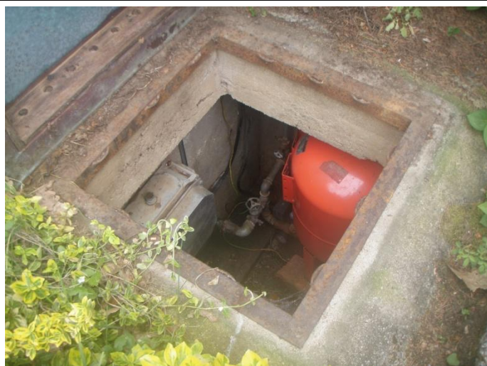
Obr 1. Vodárna I – pohled do šachty
