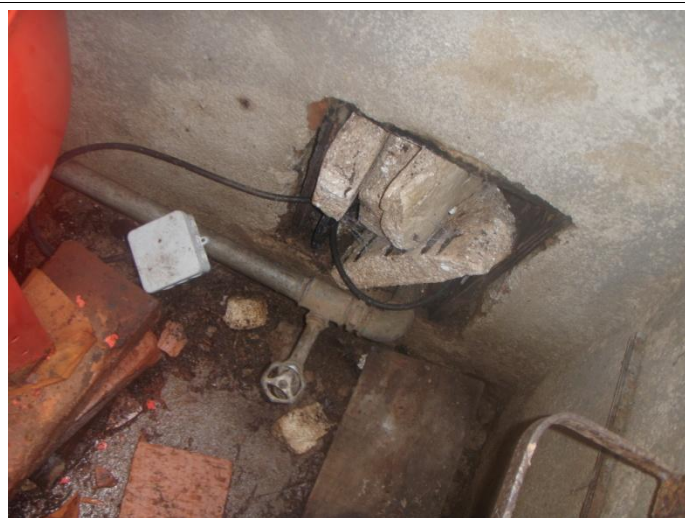
Obr 4. Vodárna I – vstupní část potrubí
