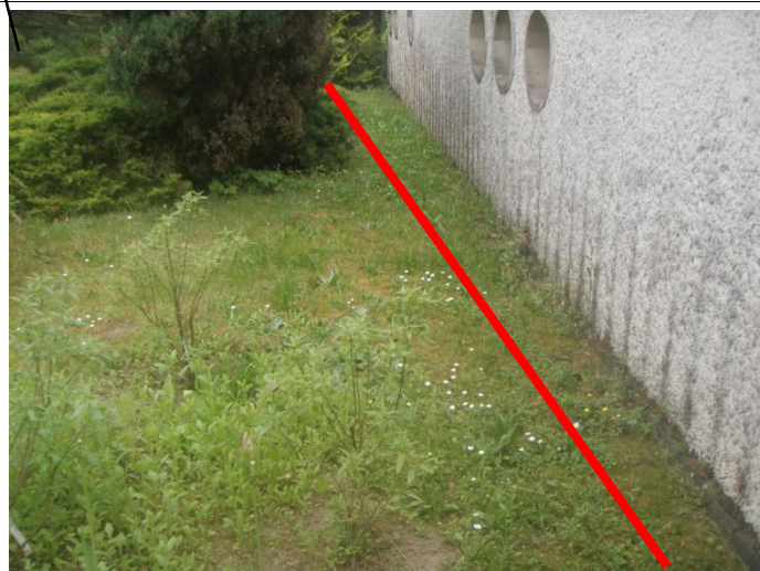
Obr 17. Úsek požadované trasy kolem opěrné zdi
