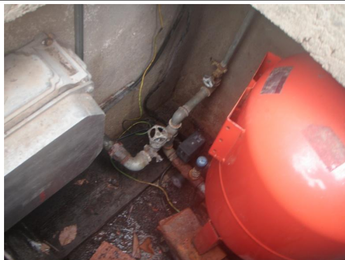
Obr 2. Vodárna I – výstupní část potrubí
