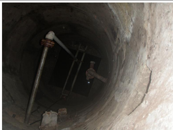
Obr 6. Studna I – pohled do studny
